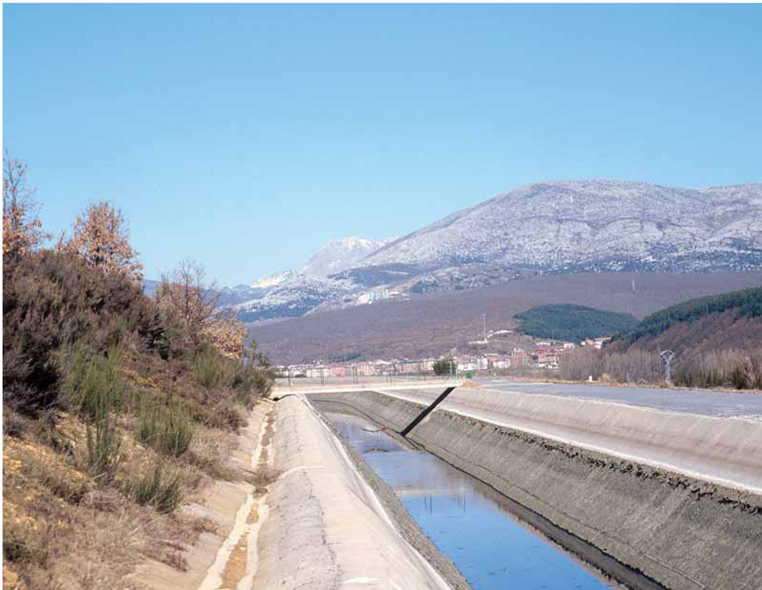
Aspecto del canal a finales de invierno cuando apenas lleva agua, se observa al fondo la localidad de Guardo (Palencia).
