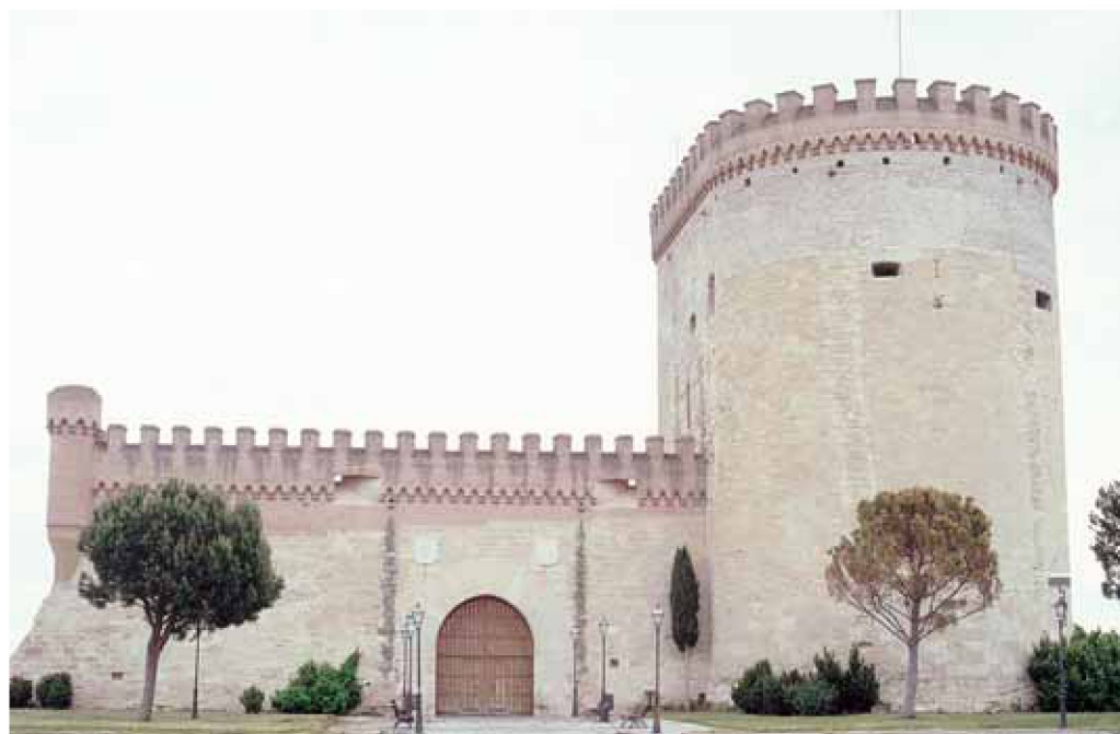
El castillo medieval nos recuerda el esplendor de la villa de Arévalo, que en la actualidad es el centro funcional de La Moraña.
