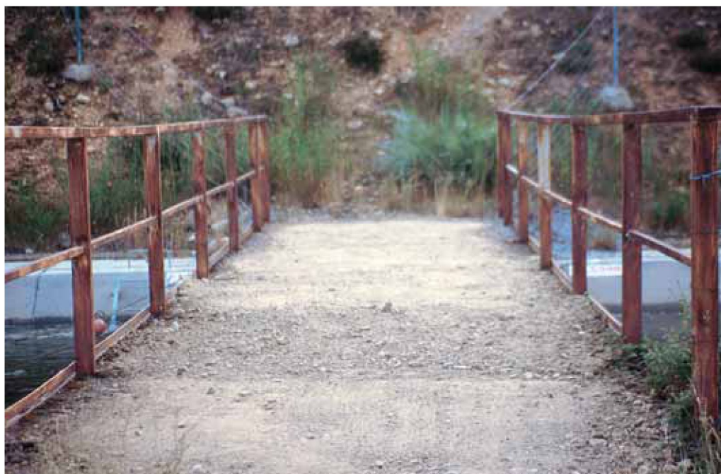
Pasarela peatonal donde se esparce arena con objeto de comprobar su importancia como paso de animales silvestres.
