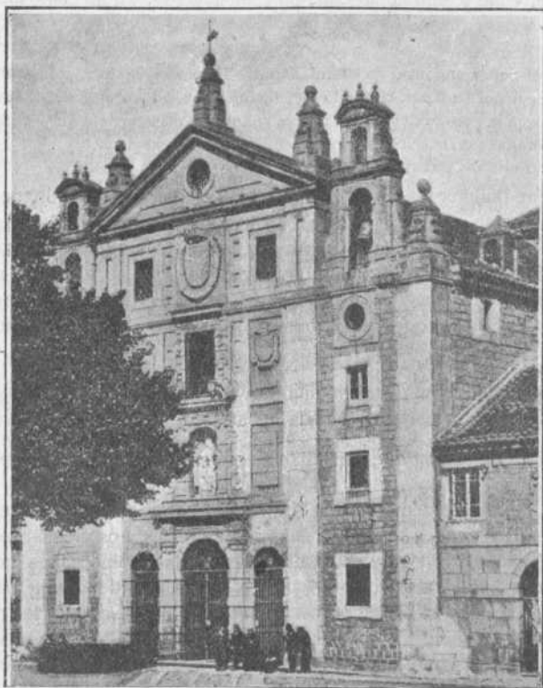
AVILA.—Convento de Padres Carmelitas levantado en el solar de la casa donde nació Santa Teresa
