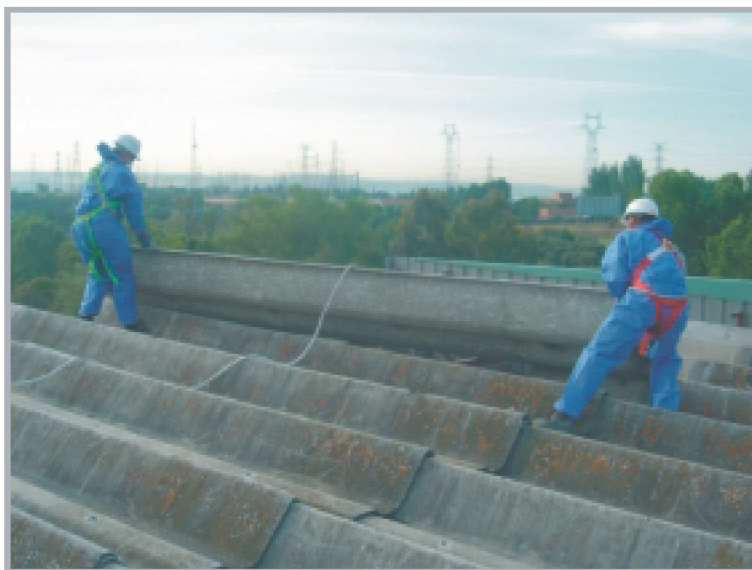
Retirada chapas de cubierta
