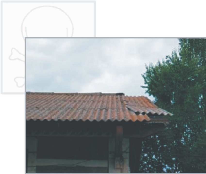
Cubierta de nave de fibrocemento
