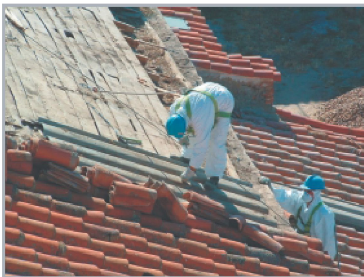
Trabajadores retirando fibrocemento bajo teja
