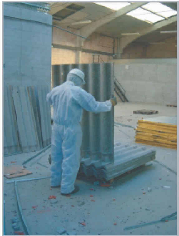
Manipulación de fibrocemento
