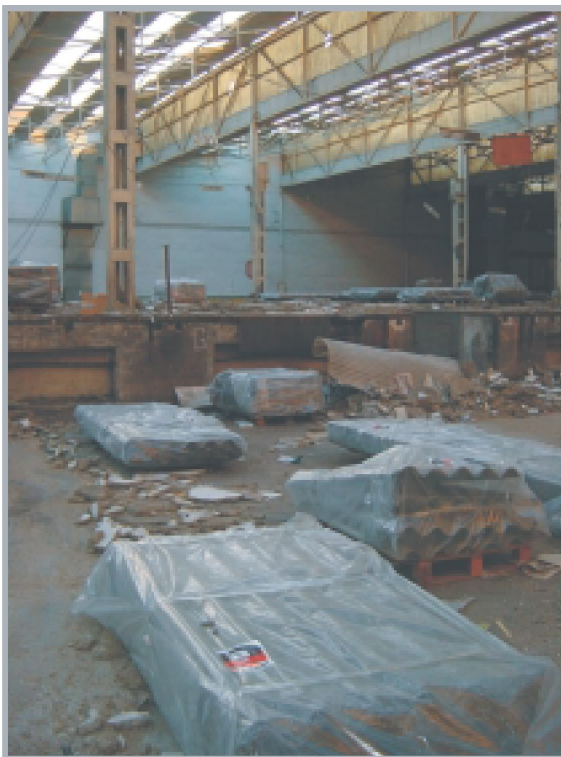
Nave con cubierta de fibrocemento
