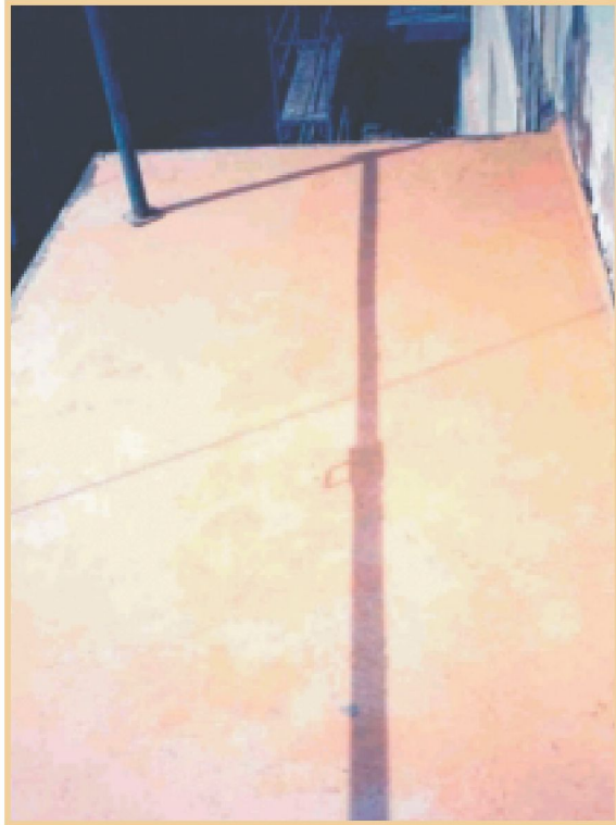
Impermeabilización de terraza
