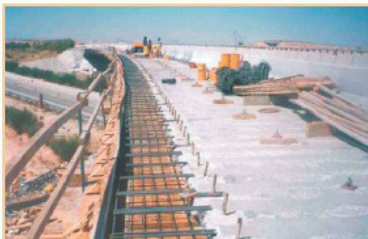
Anclajes en puente
