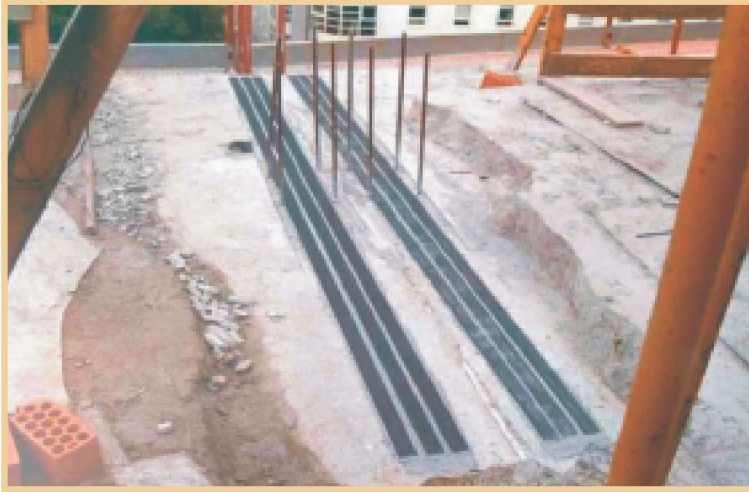
Refuerzo de forjado
