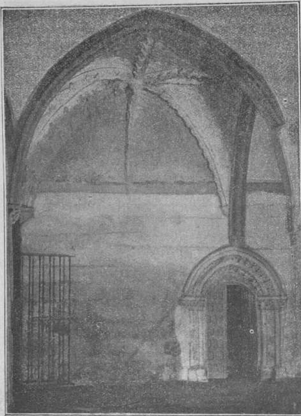
PUERTA DE LA NAVE DE SAN JUAN EVANGELISTA EN EL CLAUSTRO
