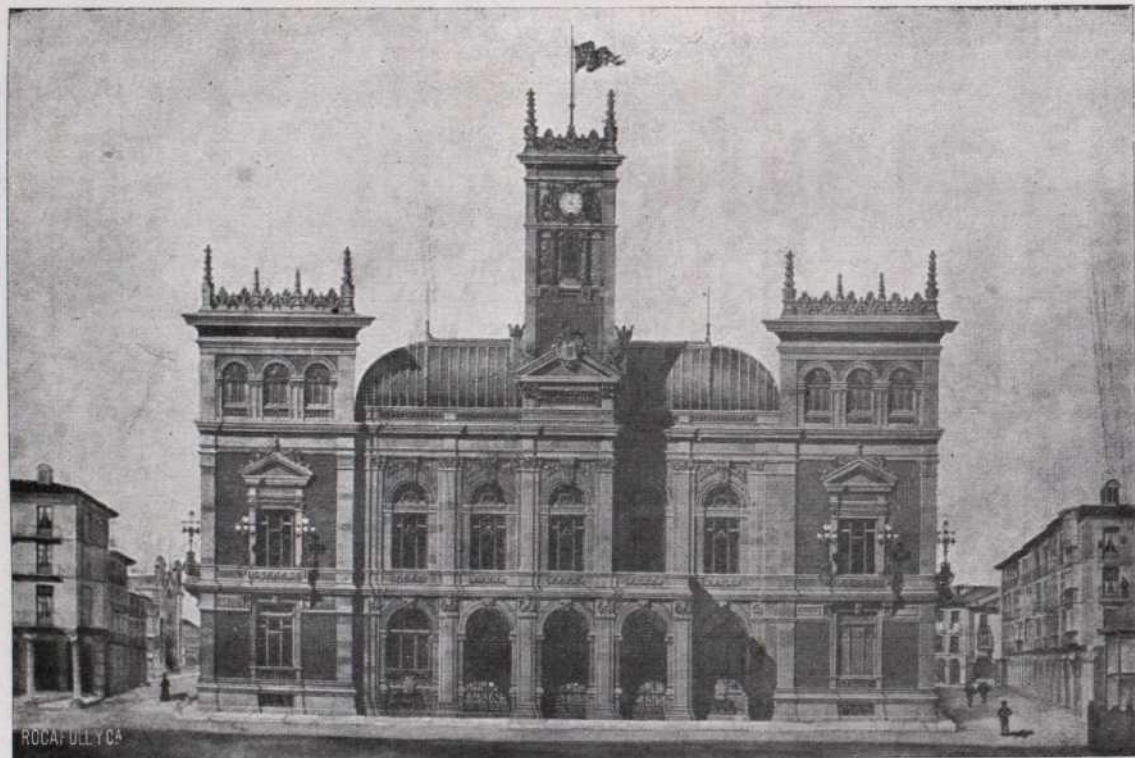
Fachada de la nueva Casa Consistorial en construcción
