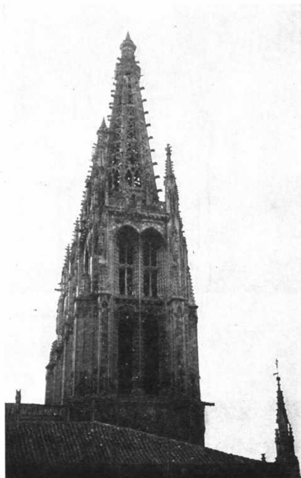
BURGOS.—Catedral. Torres de la fachada oeste.
