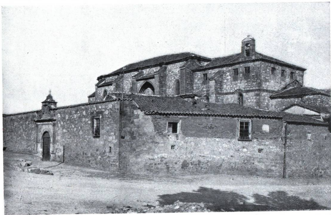
Antiguo convento de religiosas, cuya construcción gótica ha sufrido posteriores y mal entendidas reformas.
