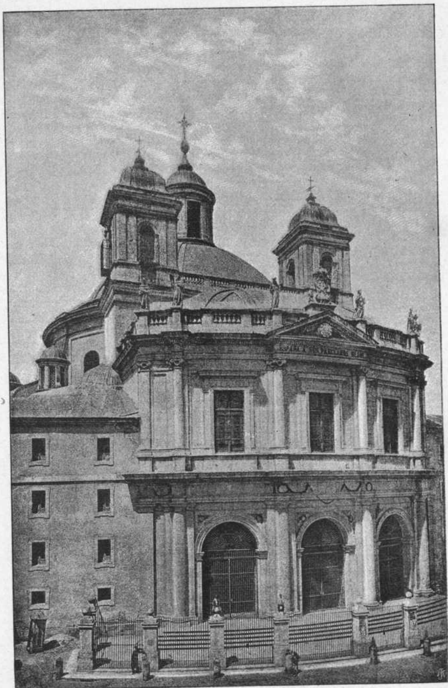
IGLESIA DE SAN FRANCISCO EL GRANDE EN MADRID (COPIA DE UNA FOTOGRAFÍA)
