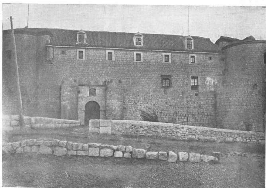
ENTRADA DE SERVICIO (Lado N.)
