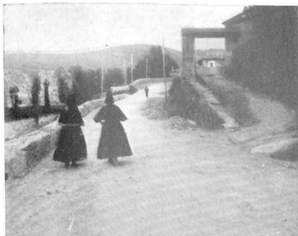
CARRETERA A CANDELARIO
