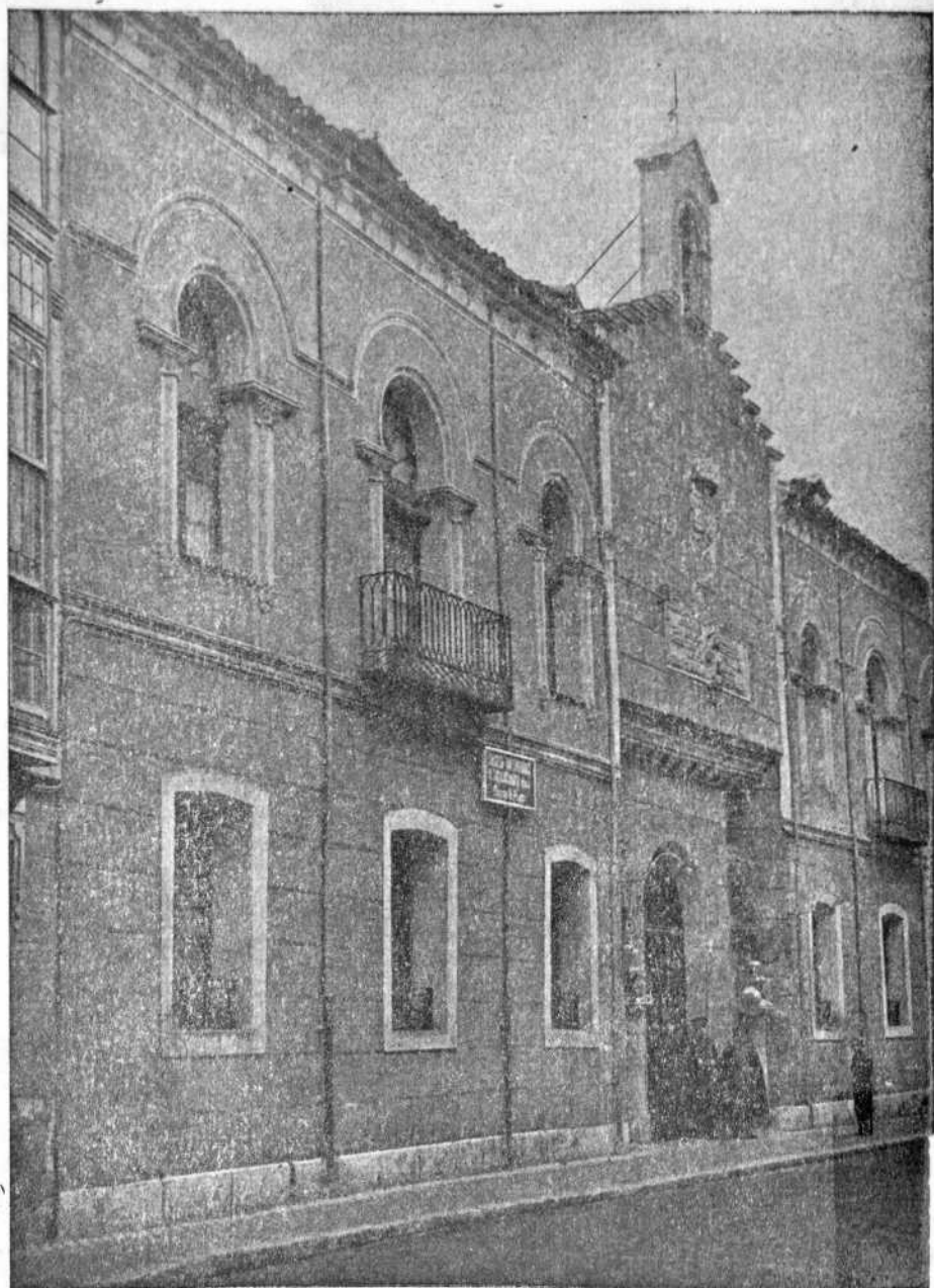
Fachada del Hospital de Esgueva (estado actual).
