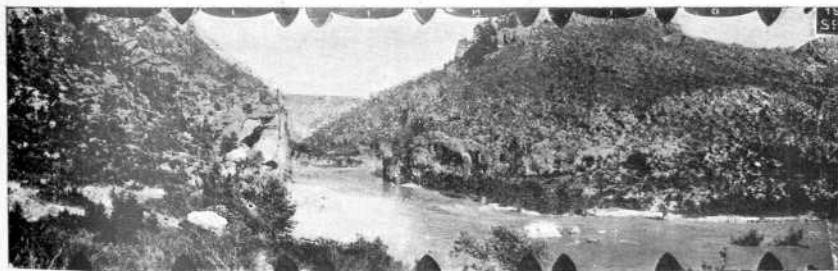
Fotografía n.º 2. —SALTO DE DOS AGUAS: Emplazamiento de la presa visto desde aguas abajo.
