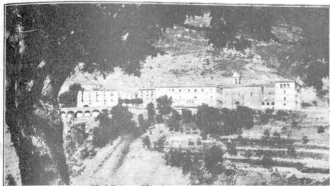
VALVANERA. Vista general del Santuario
