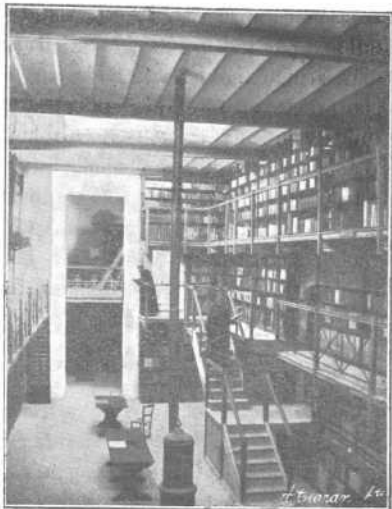
SILOS. Vista parcial de la biblioteca.
