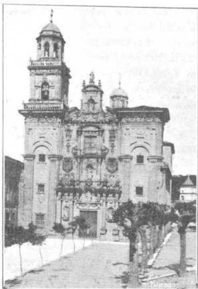
LORENZANA. Fachada de la Iglesia
