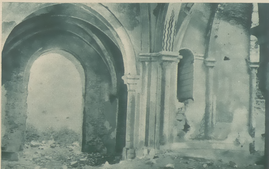
Este cruce de nave permite admirar alguno de los maravillosos arcos que coronan las bóvedas de la iglesia
