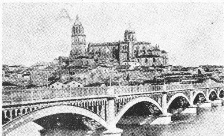
LA CATEDRAL Y EL PUENTE NUEVO
