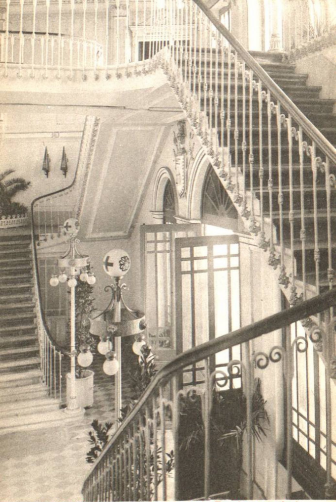
5-VALLADOLID. Academia de Caballería. Escalera principal
