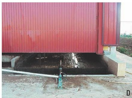
Las fotos A, B y C muestran detalles constructivos de la arrobadera y el riel por el que circula la misma, la foto D muestra el final del trayecto de la arrobadera donde se localiza la fosa de deyecciones.
