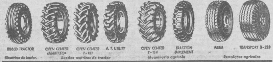
RIBBED TRACTOR OPEN CENTER «MARTILLO» OPEN CENTER T-131 A. T. UTILITY OPEN CENTER T-114 TRACCIÓN IMPLEMENT PARA TRANSPORT 8-213
