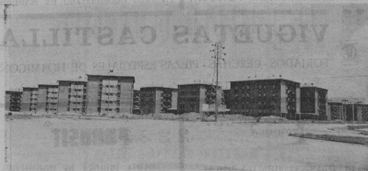
He aquí el grupo de quinientas viviendas construídas, bajo promoción del Ayuntamiento, en el barrio de Villimar, con las que se ha de paliar en parte la falta de alojamientos de tipo social.
