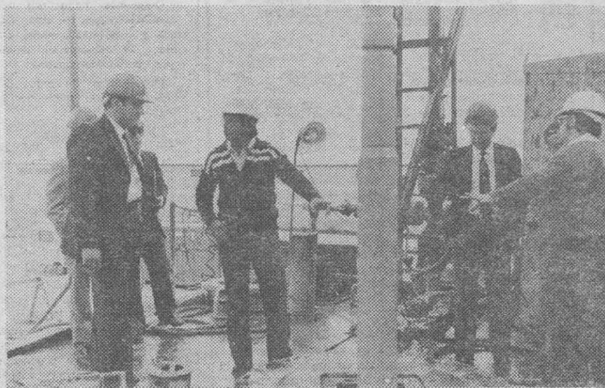
En la mañana de ayer, comenzaron los primeros trabajos del sondeo del aprovechamiento geotérmico que llevan a cabo técnicos de la empresa «Adaro» del I.N.I., para la búsqueda de agua caliente, a una profundidad de unos 2.500 metros y según los estudios iniciales con un poder calorífico de 90 grados centígrados, si se confirman esas previsiones.
