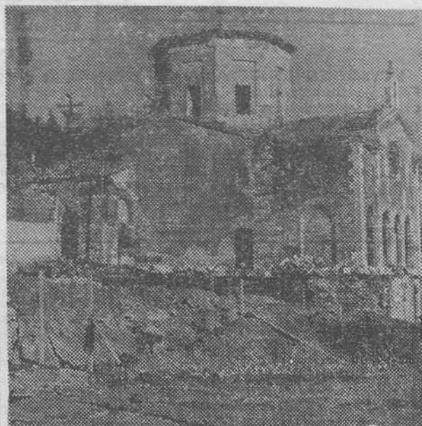
Ultimos vestigios de la antigua capilla del cementerio viejo, cuando se completó su demolición, para iniciar los trabajos de construcción del actual Seminario diocesano. — (Foto «FEDE»).
