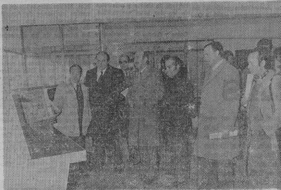
En la sala de mandos de la estación potabilizadora, los técnicos explicando a autoridades e informadores las características de las instalaciones. — (Foto FEDE)
