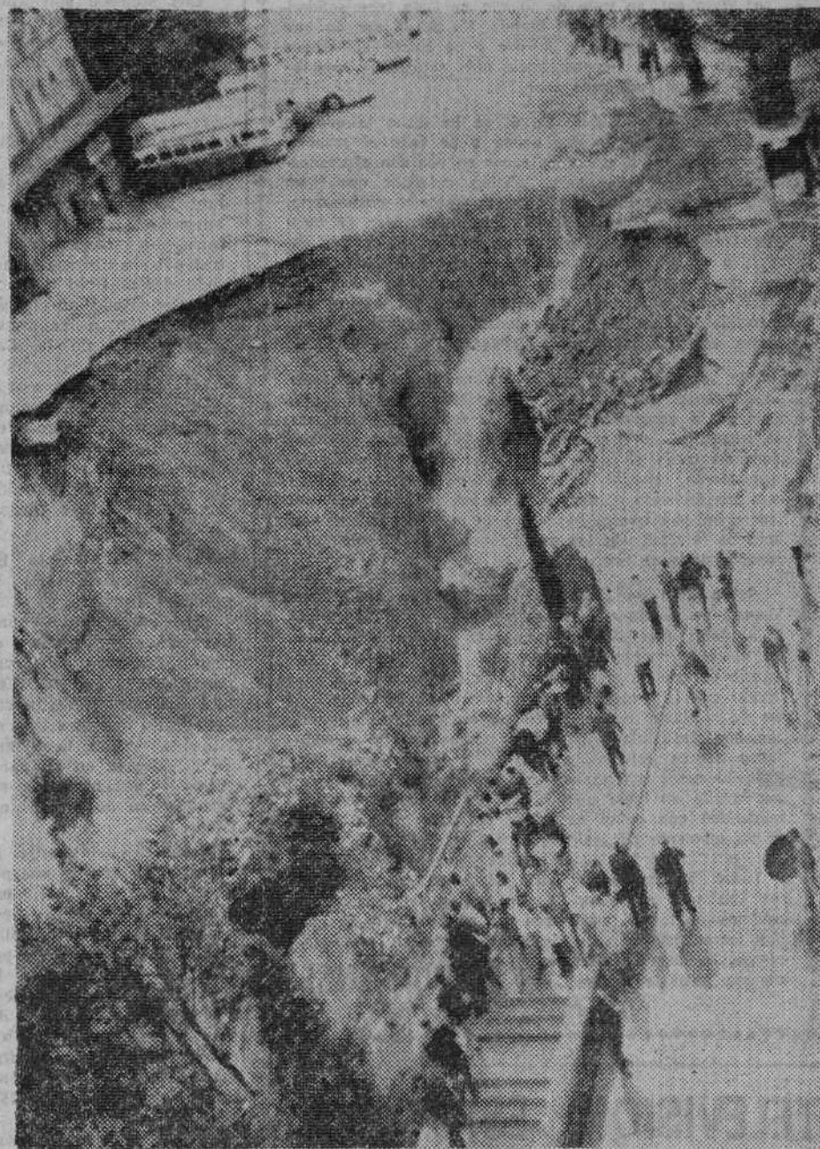
Monasterio de Montserrat. — Impresionante socavón producido por las inundaciones en las cercanías de la estación de llegada del funicular a este monasterio. — (Telefoto Cifra Gráfica)
