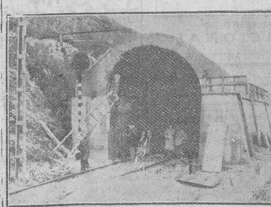
Busgondo (León). — Una de las entradas al túnel artificial de 300 metros de longitud, que actualmente se construye entre esta estación y el túnel de "La Peruca", para evitar la interrupción del tráfico con Asturias, en la época invernal, a consecuencia de los temporales de nieve. — (Foto Cifra)
