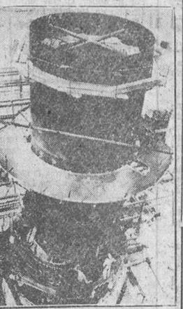
Esta es una sección del reactor generador de una instalación capaz para doce mil quinientos barriles de petróleo diarios, en la nueva refinería de petróleo que se está construyendo en Fremantle (Australia) por la Anglo Iranian. El coste total de la refinería se eleva a tres mil millones de pesetas y se calcula que al cabo de un año de funcionamiento, habrá depurado tres millones de toneladas de petróleo crudo. — (F. Gil del Espinar)
