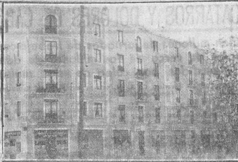
El bloque de viviendas construido en la calle del Molinillo
