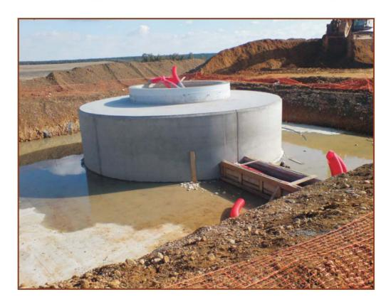
El desencofrado de los diferentes elementos de obra se debe realizar guardando el mismo intervalo de tiempo. Esto se justifica desde el punto de vista de la calidad superficial, ya que el tinte de la superficie está vinculado o influenciado por el tiempo durante el cual permanece aislado del exterior.
