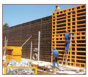
ESPÁRRAGO DE UNIÓN: elemento que sirve de unión entre los panel-pilar cuando estos se montan en forma de aspa para realizar los pilares. También sirve para realizar los tapes de muros con los rigidizadores.
