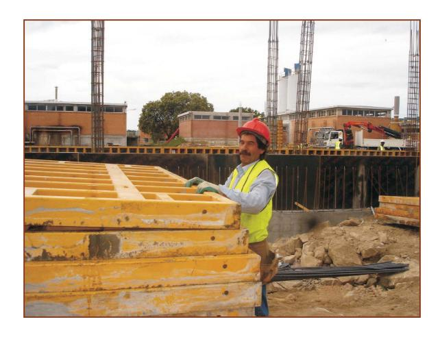
Una vez desencofrado se apoyará el conjunto en unos bastidores donde se procederá a la limpieza de estos y al desmontaje del conjunto.
