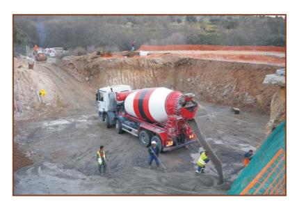
Antes del inicio del vertido del hormigón, el capataz o encargado revisará el buen estado de seguridad de las entibaciones de contención de tierras de los taludes de vaciado que interesan a la zona de muro que se va a hormigonar, para realizar los refuerzos o saneos que fueran necesarios.
