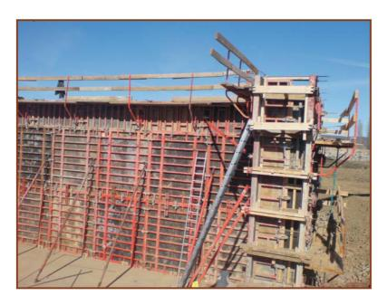
Los puntos de apoyo de las escaleras de mano deberán asentarse sólidamente sobre un soporte de dimensión adecuada y estable, resistente e inmóvil, de forma que los travesaños queden en posición horizontal.
