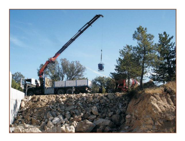
Se vigilará el buen comportamiento de los encofrados durante el vertido del hormigón, paralizándolos en el momento que se detecten fallos. No se reanudará el vertido hasta restablecer la estabilidad mermada.
