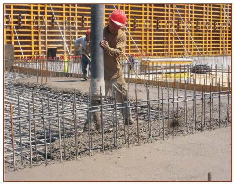
Son preferibles los vibradores de aguja para la compactación del hormigón en obra, dejando la vibración externa a través de los paneles, solamente para aquellos casos en los que las agujas no son accesibles o para piezas enmoldadas en taller.
