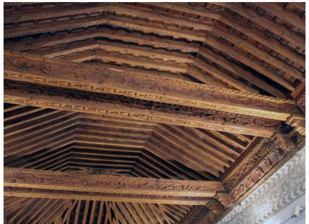
armadura de limas moamares. Nave.
