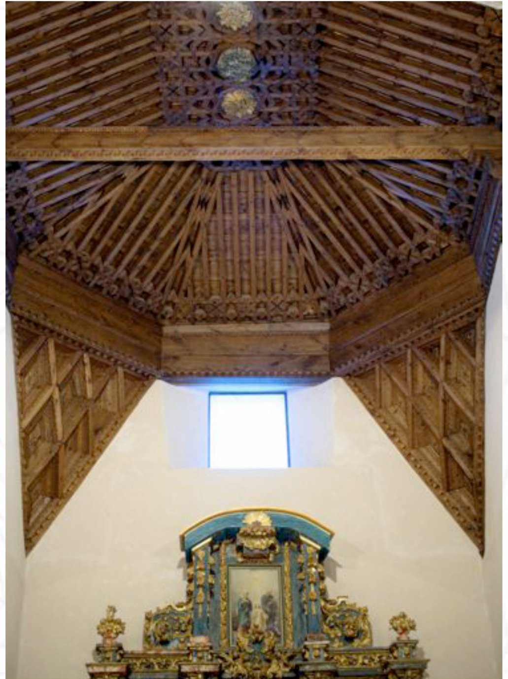
armadura de limas moamares. Presbiterio
