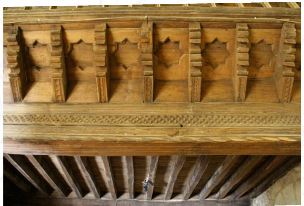
forjado del coro y detalle de las cintas recortadas en forma de estrella de 8 puntas
