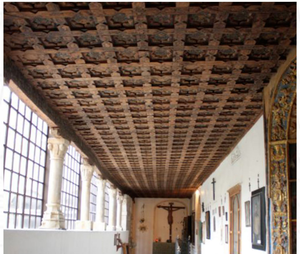
forjado del claustro
