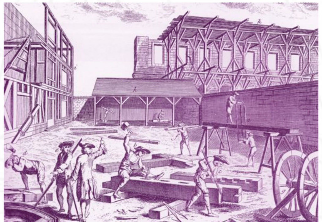
grupo de carpinteros realizando trabajos de construcción
