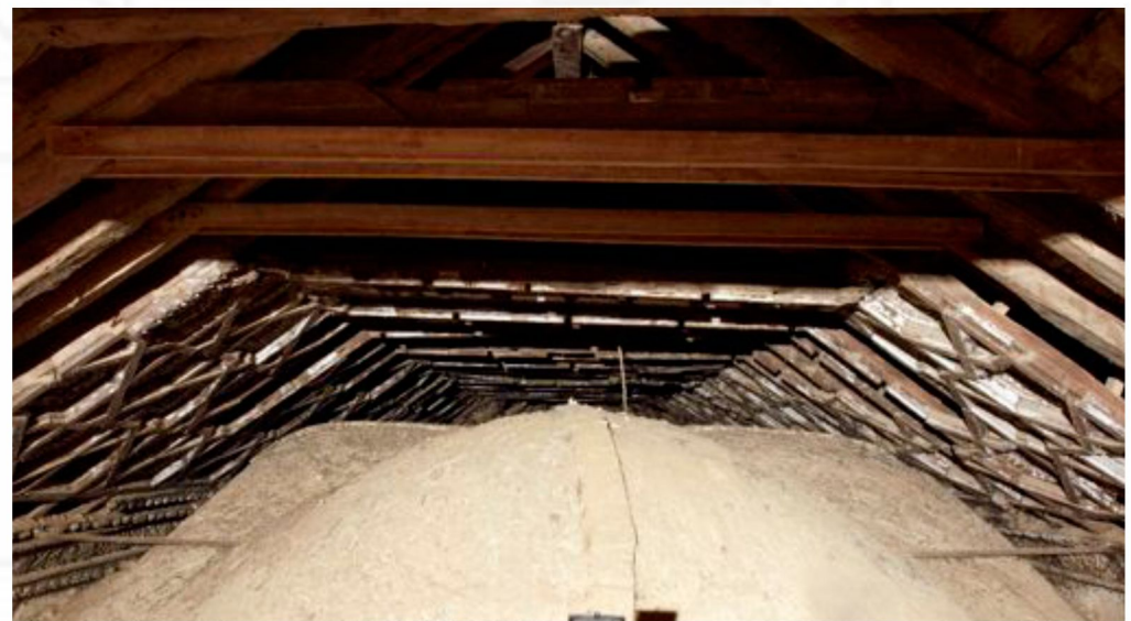
armadura oculta tras las bóvedas
