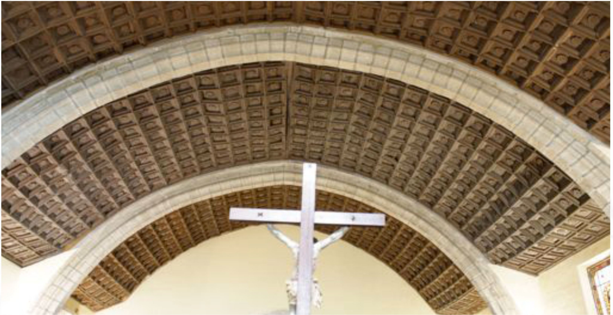
aspecto general del forjado sobre arcos diafragma
