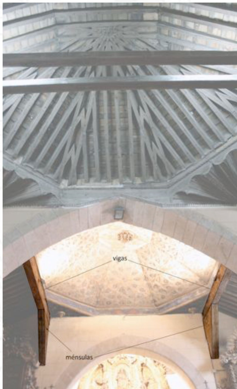
apoyo sobre ménsulas y vigas de la armadura del crucero
