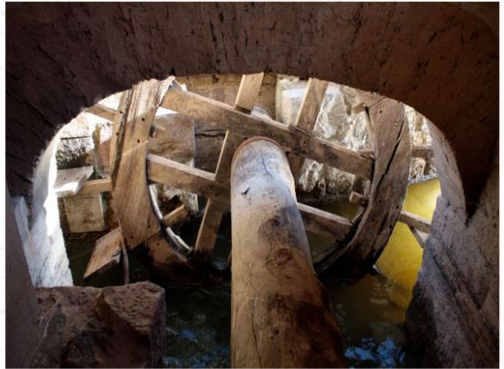
aceñas de Olivares. Zamora. Obra de carpintería de lo prieto con origen en el S. X
