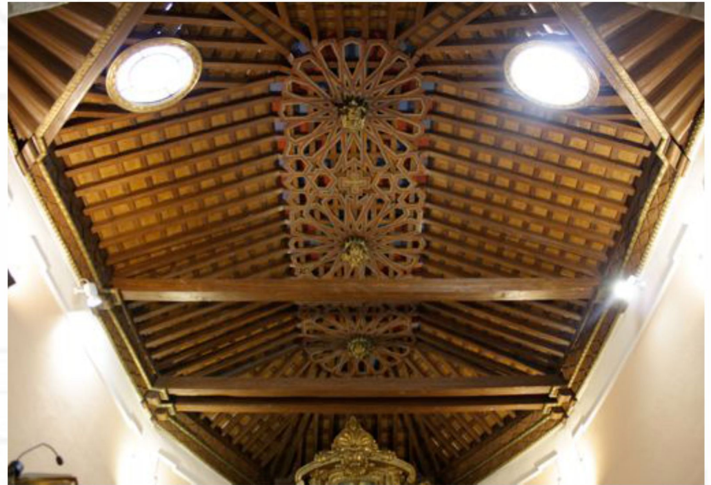
ojos de buey para permitir el paso de la luz a través de la cubierta del presbiterio
