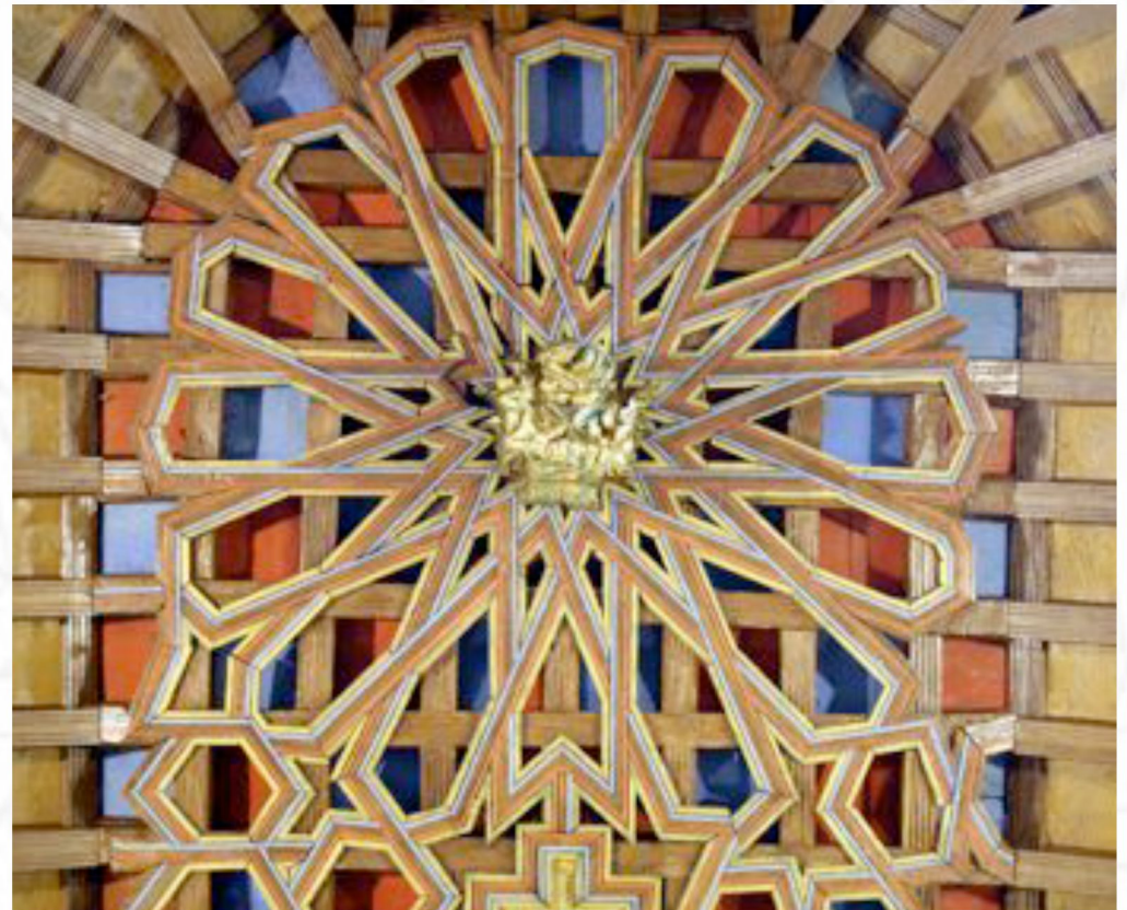
rueda de lazo de 16 puntas en el extremo del almizate
