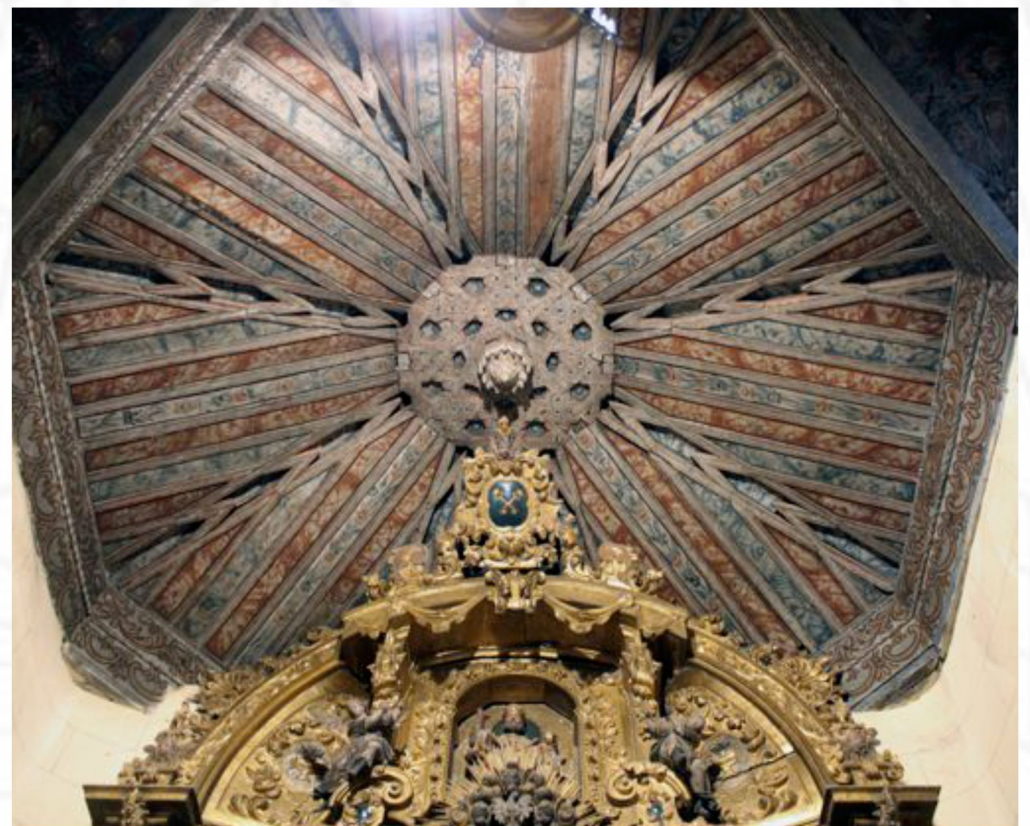
armadura de cubierta del presbiterio
