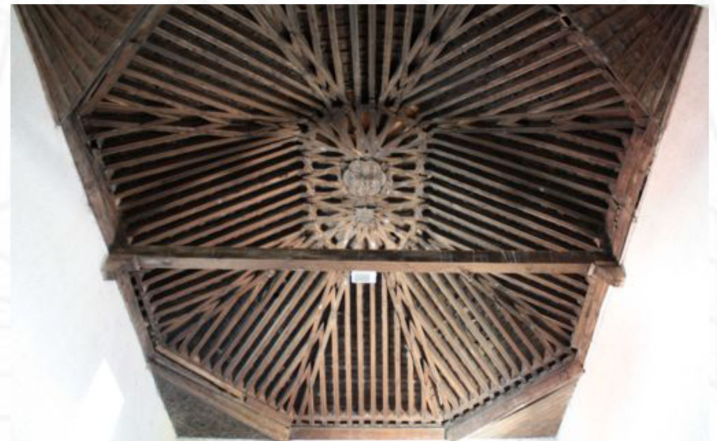
armadura de limas moamares. Presbiterio
