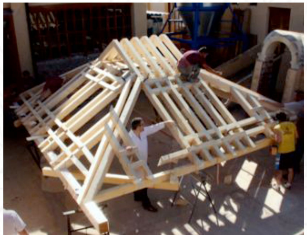
carpinteros de lo blanco elaborando una armadura de cubierta foto: exposición "Construyendo firmamentos". Junta de Castilla y León (fotografía y video Carrera)
