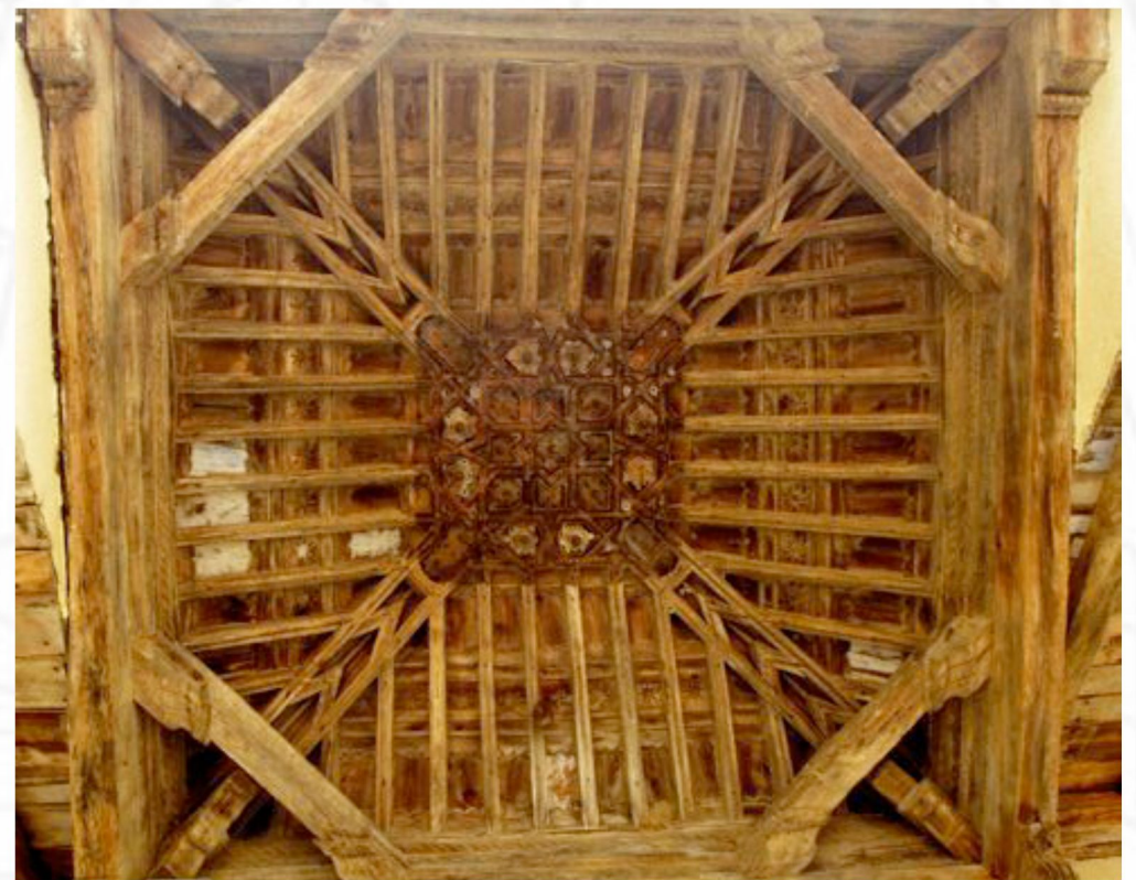
armadura del pórtico
