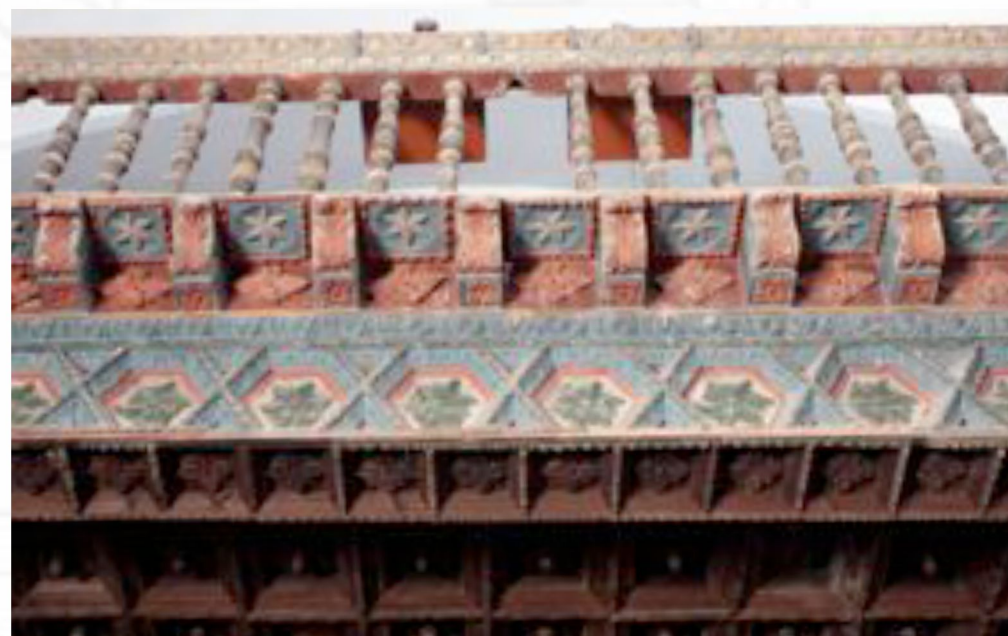
frente del coro con viga mayor, asnados, balaustres y barandal superior
