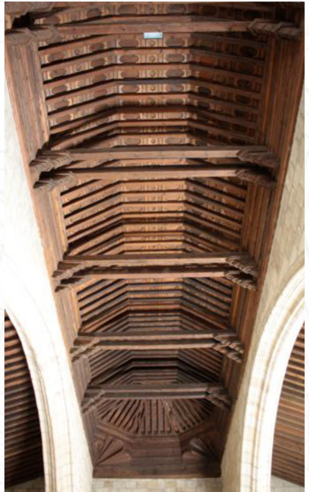
armadura de la nave central. San Juan de Puerta Nueva. Zamora
