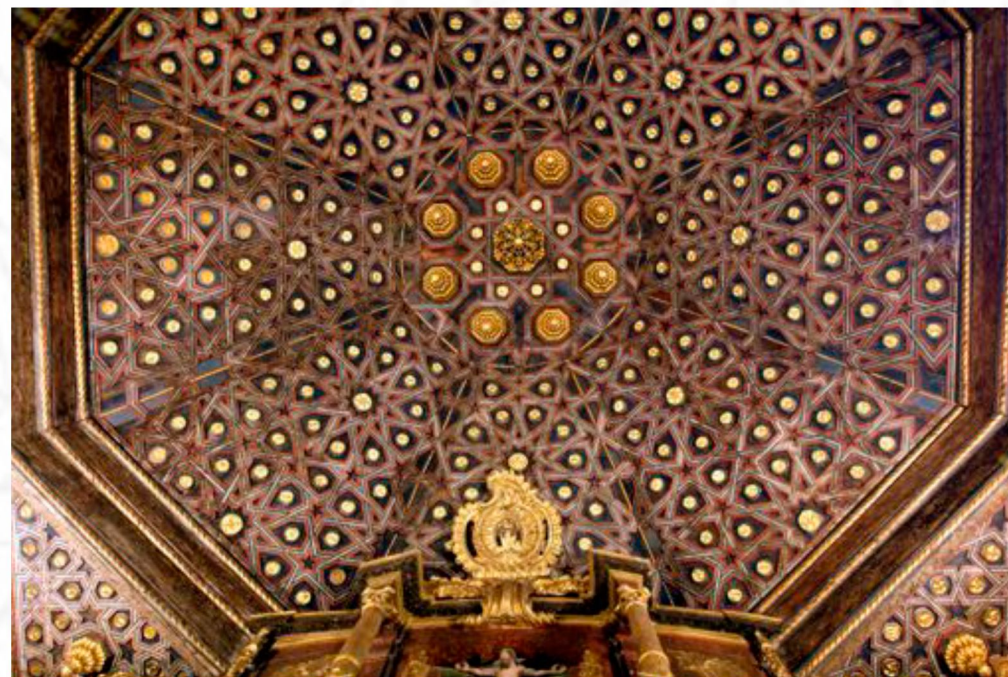
armadura de cubierta de la capilla mayor
