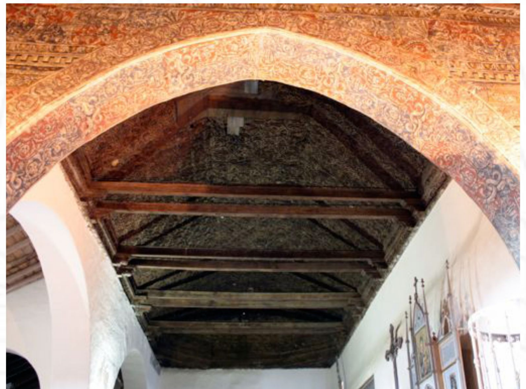
aspecto general de la armadura de la nave
