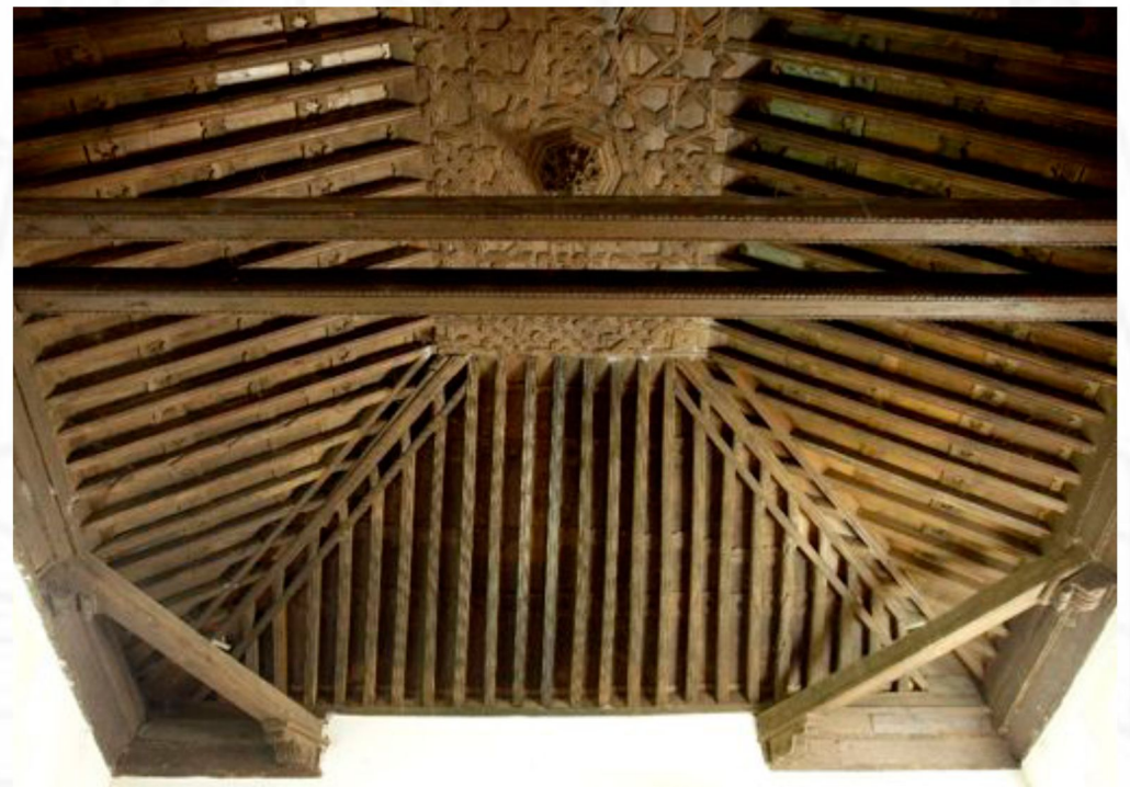
aspecto general de la armadura de la nave
