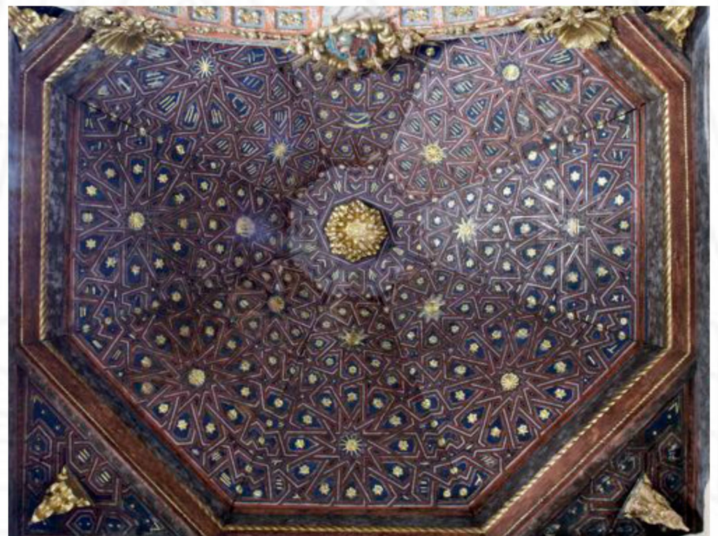
armadura de cubierta de la capilla mayor
