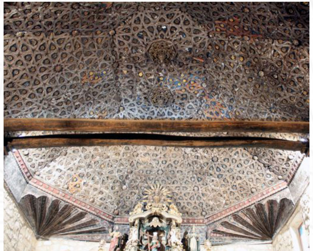
armadura ataujerada del presbiterio
