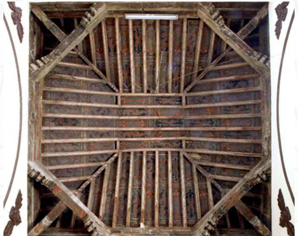
armadura de cubierta del presbiterio
