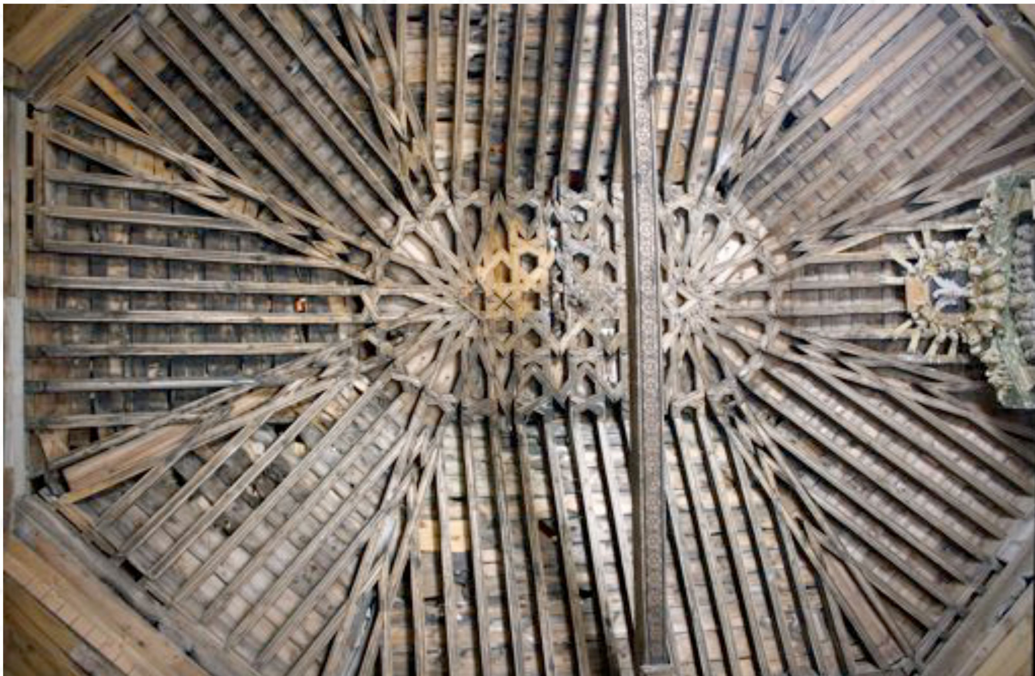
aspecto general de la armadura de limas moamares del presbiterio (1550-1564). Iglesia de San Miguel Arcángel. Pízarra (Salamanca)
