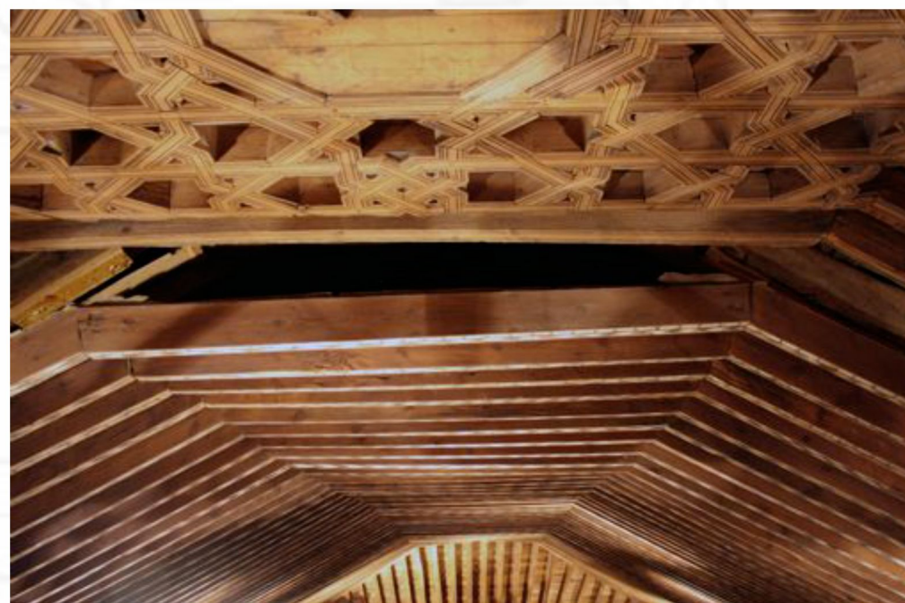
encuentro de las dos armaduras de cubierta situadas sobre las bóvedas de yeso
