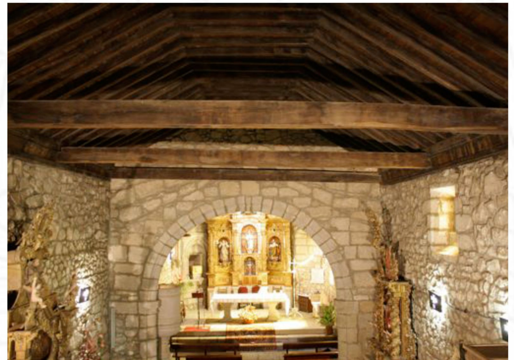
armadura de par y nudillo. Nave
