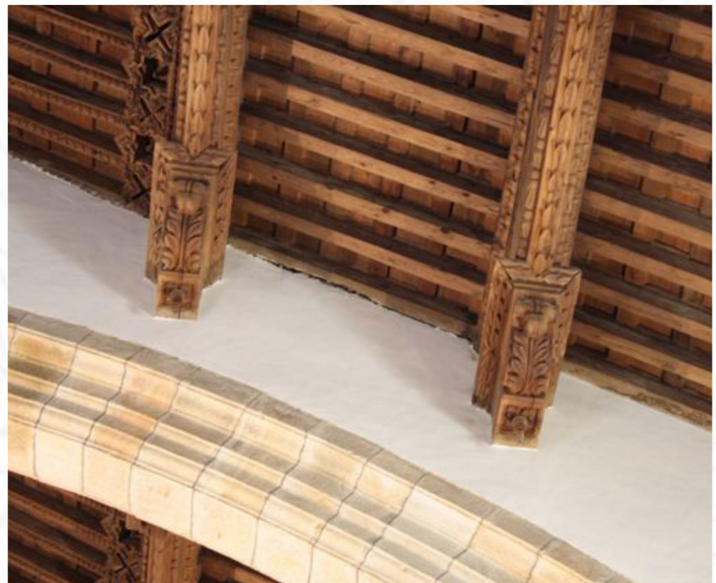
detalle de vigas “madres” para compartimentar el espacio
