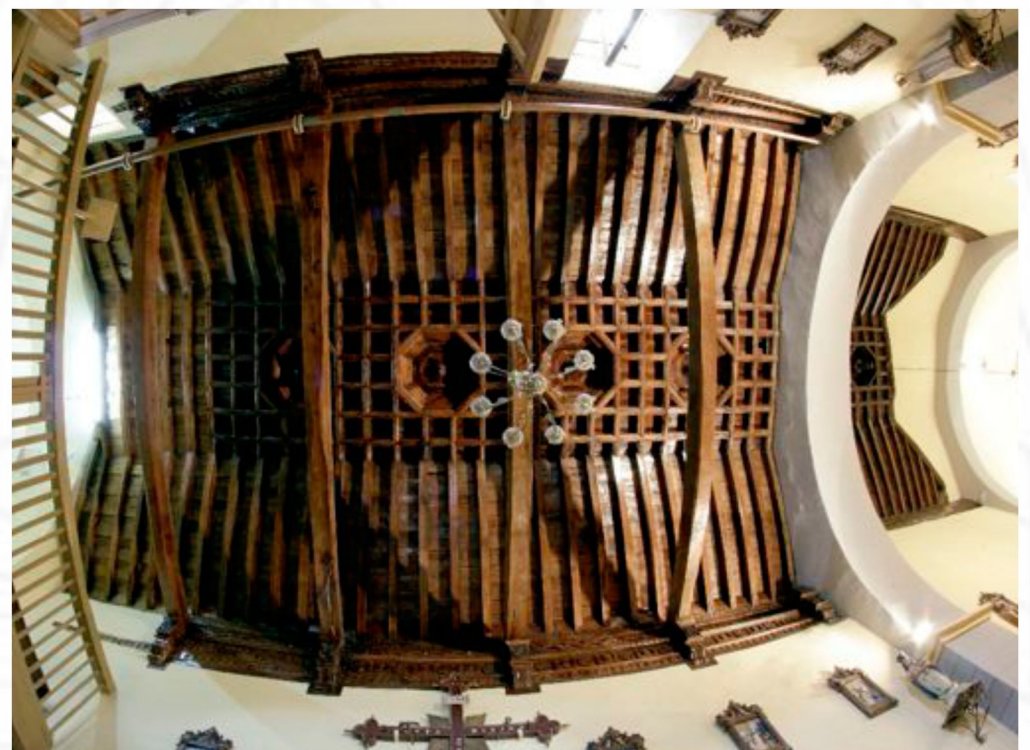
armaduras de cubierta de la nave y el crucero
