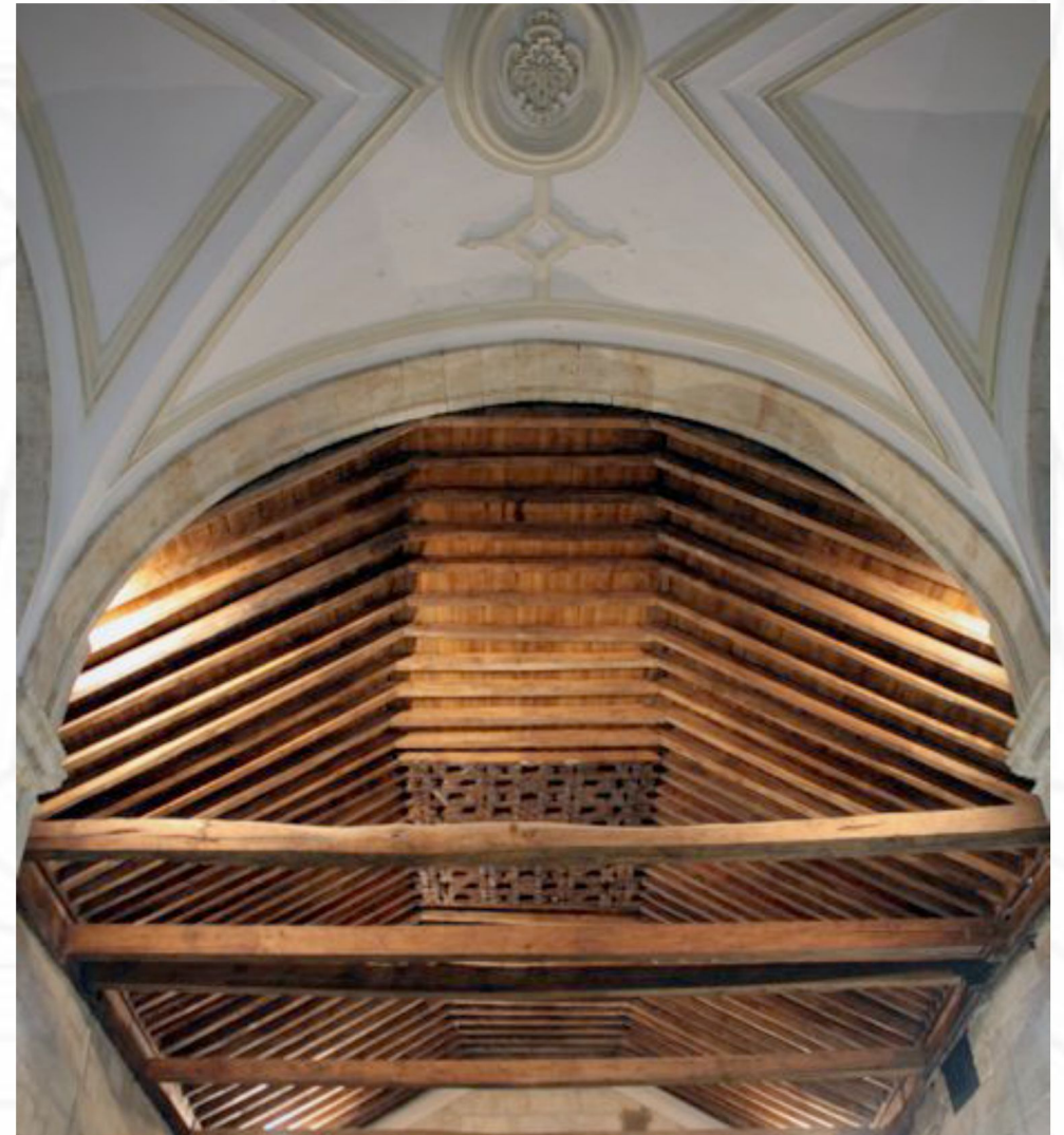
emplazamiento del antiguo almizate dentro de la armadura de cubierta
