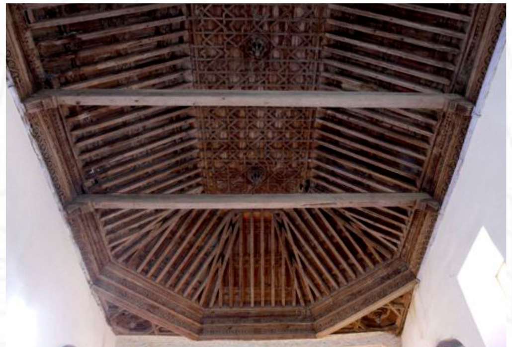
armadura de cubierta de la nave
