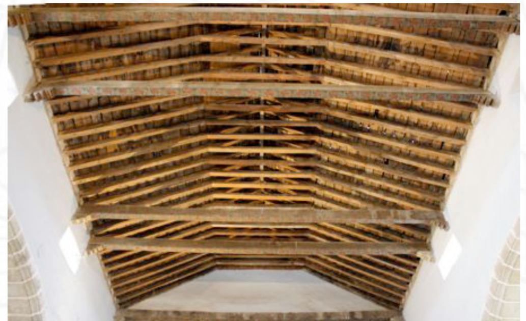
armadura de par y nudillo de la nave central
