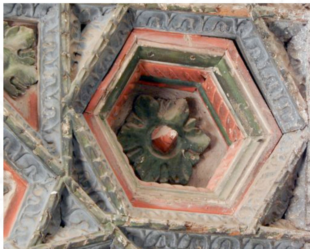
arteson hexagonal para cerrar el hueco entre viga mayor y jabalcón
