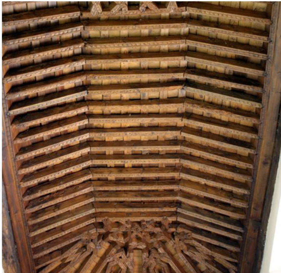
armadura de limas moamares en la capilla de la Epístola
