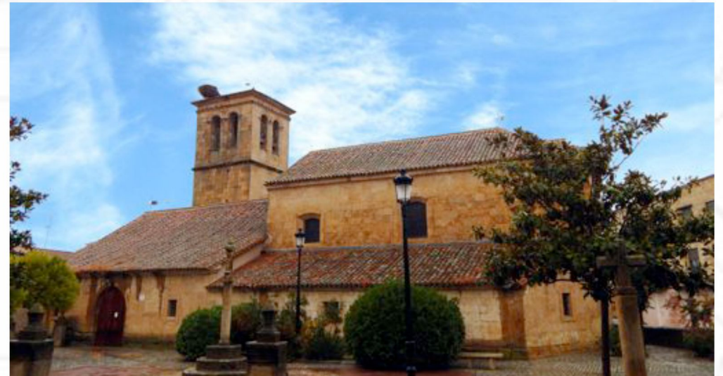
exterior de la iglesia de San Miguel Arcángel. Villamayor (Salamanca)
