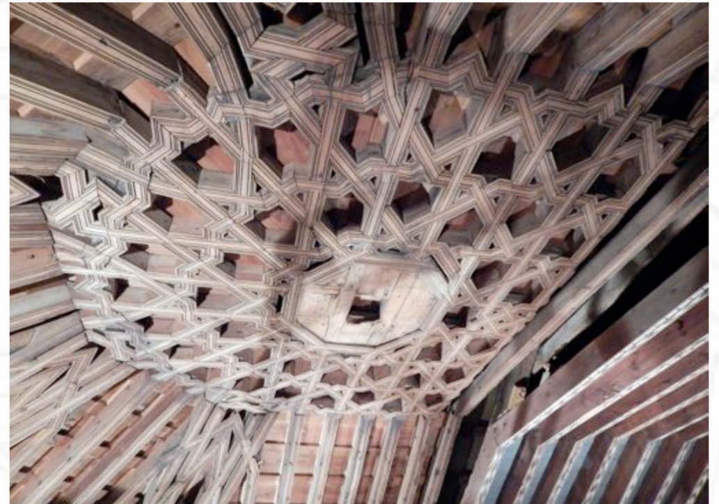
almizate de la armadura de cubierta del siglo XVI
