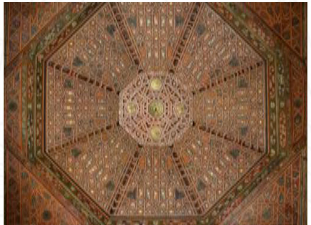
aspecto general de la armadura de cubierta
