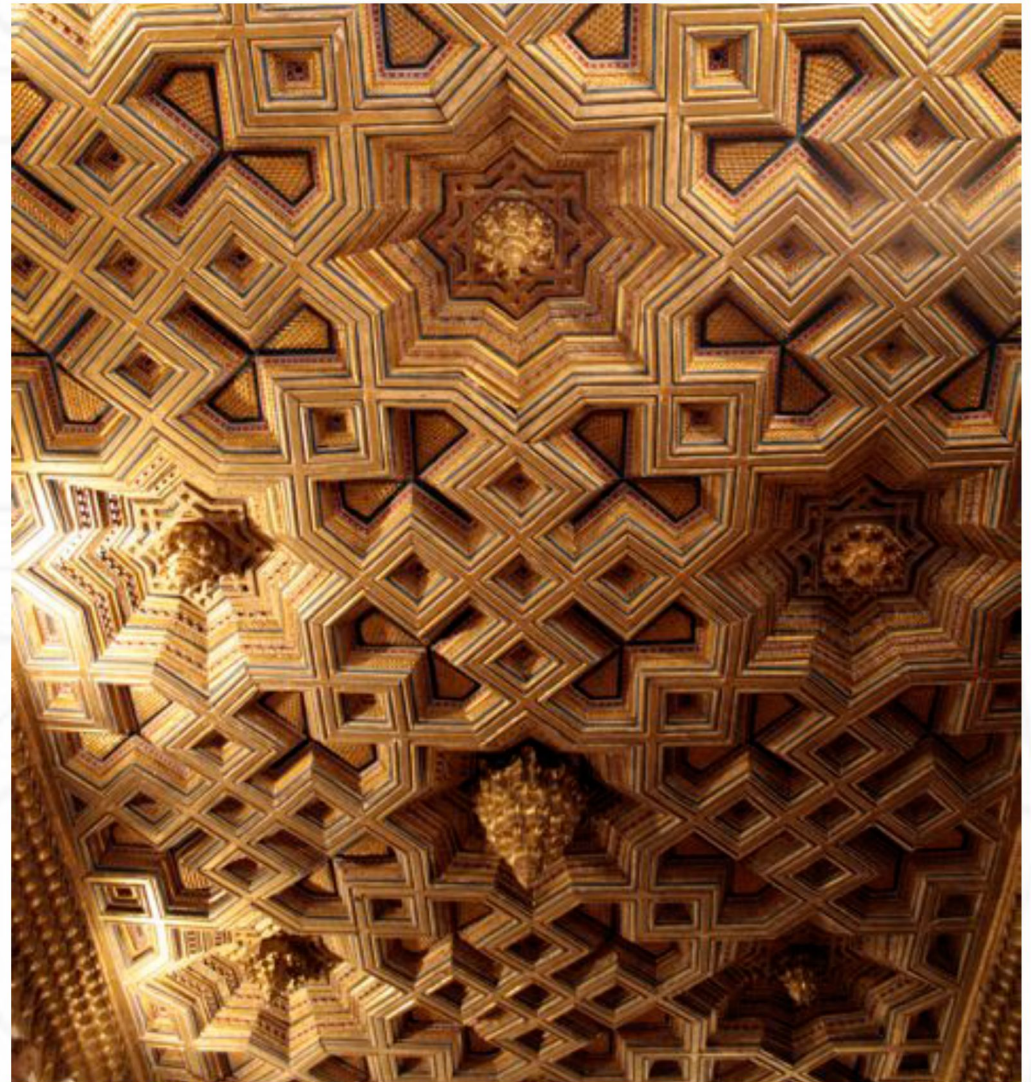
alfarje con estrellas de 8 puntas y racimos de mocárabes
