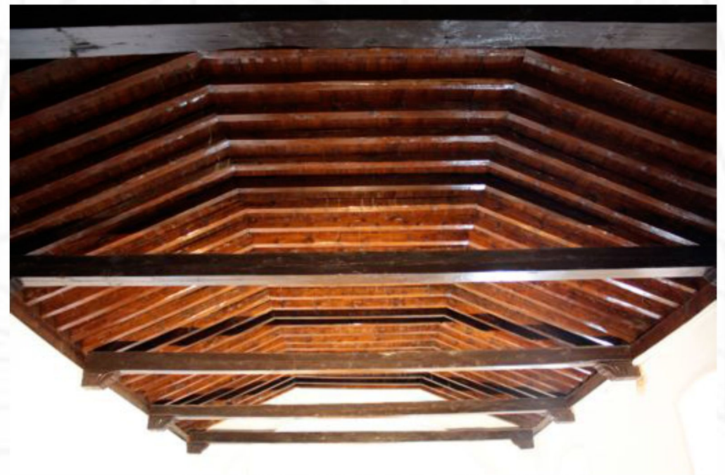
aspecto general de la armadura de par y nudillo
