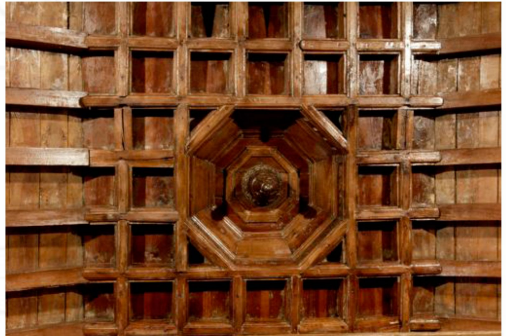
detalle de uno de los artesones octogonales situados en el almizate foto: exposición "Construyendo firmamentos". Consejería de Cultura y Turismo. Junta de Castilla y León
