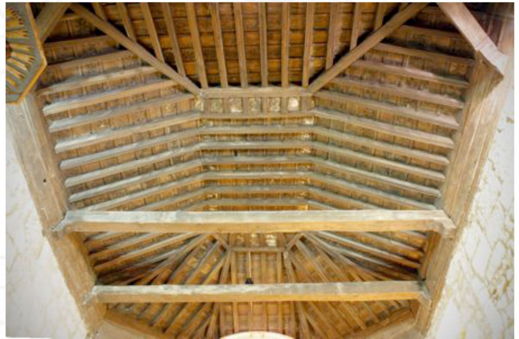
armadura de lima bordón. Presbiterio
