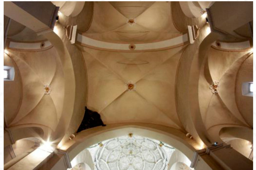
bóvedas y cúpula de la iglesia de Santa María en La Bañeza
