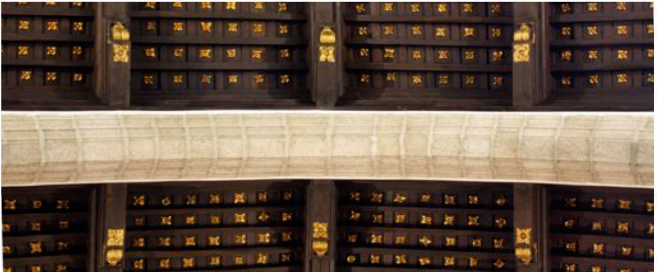
detalle del asiento de canes o asnados y vigas sobre un arco diafragma. Iglesia de San Juan Bautista (Béjar)
