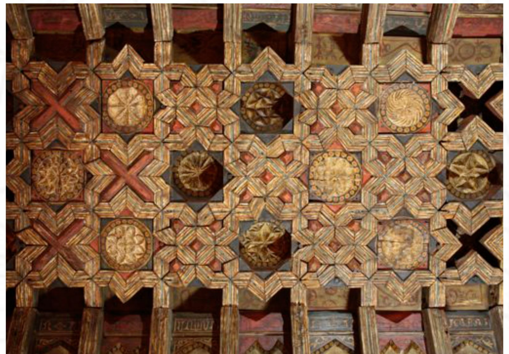
detalle de la lacería en el almizate de la armadura medieval
