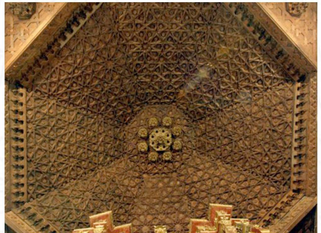
armadura de cubierta del presbiterio
