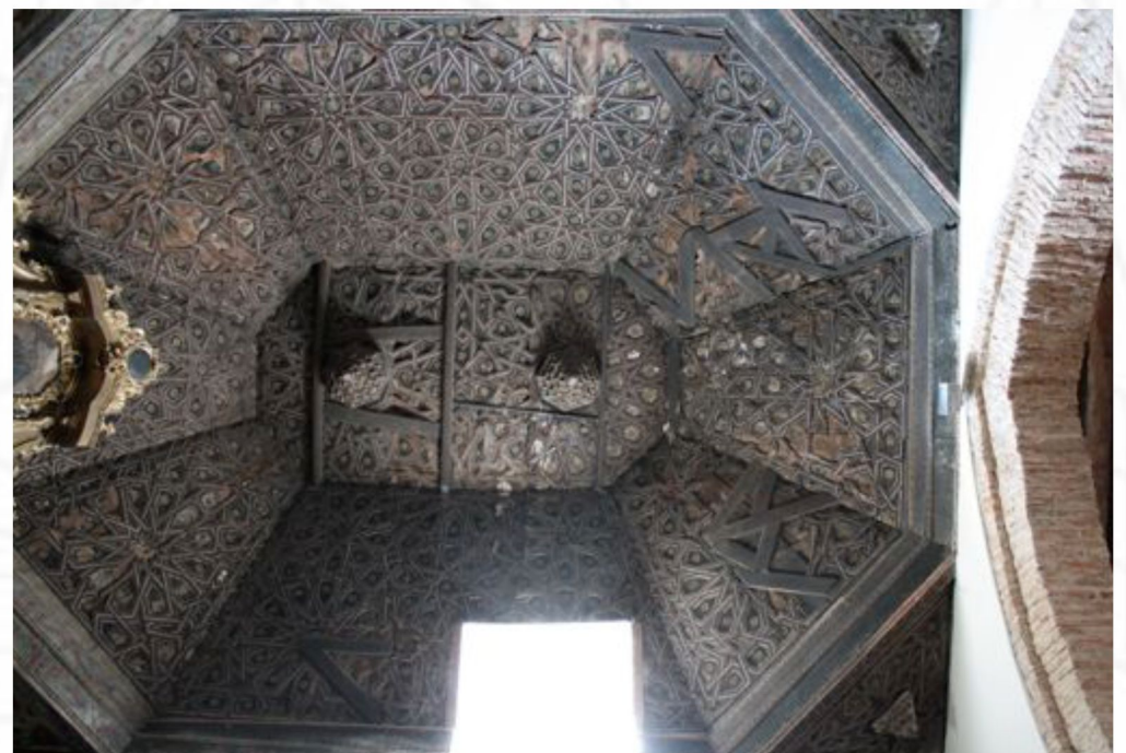
aspecto general de la armadura de la capilla mayor
