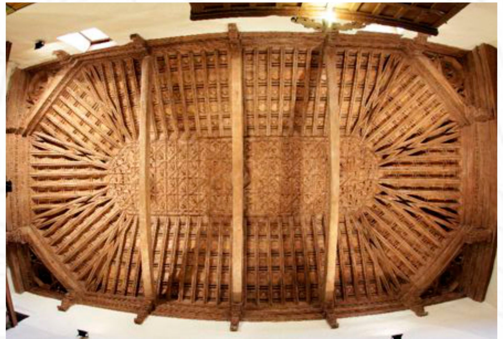
armadura de limas moamares de la nave
