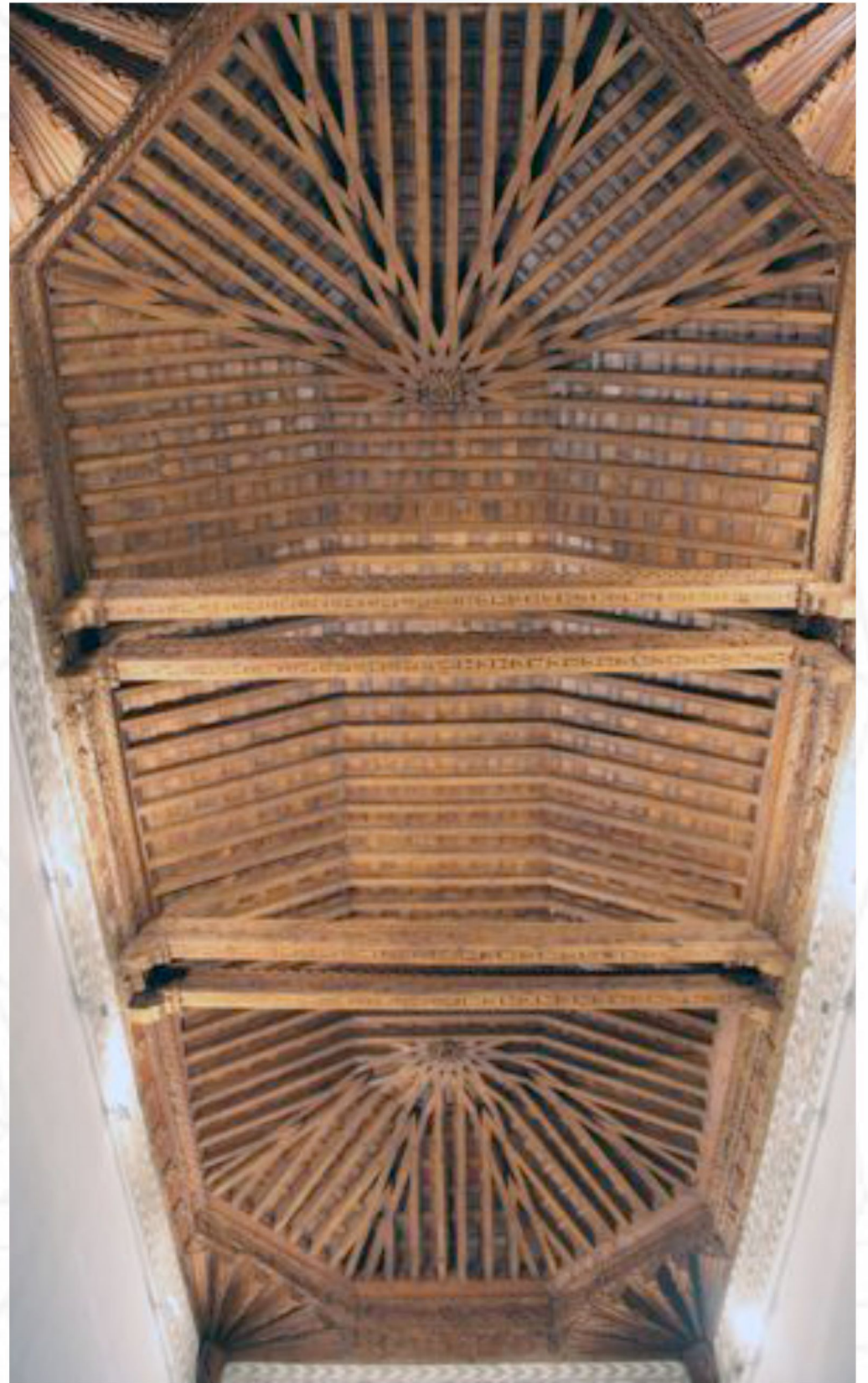
aspecto general de la armadura de cubierta
