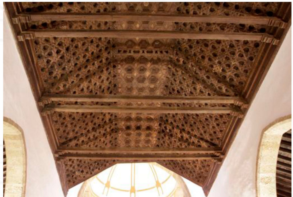
armadura de cubierta de la nave
