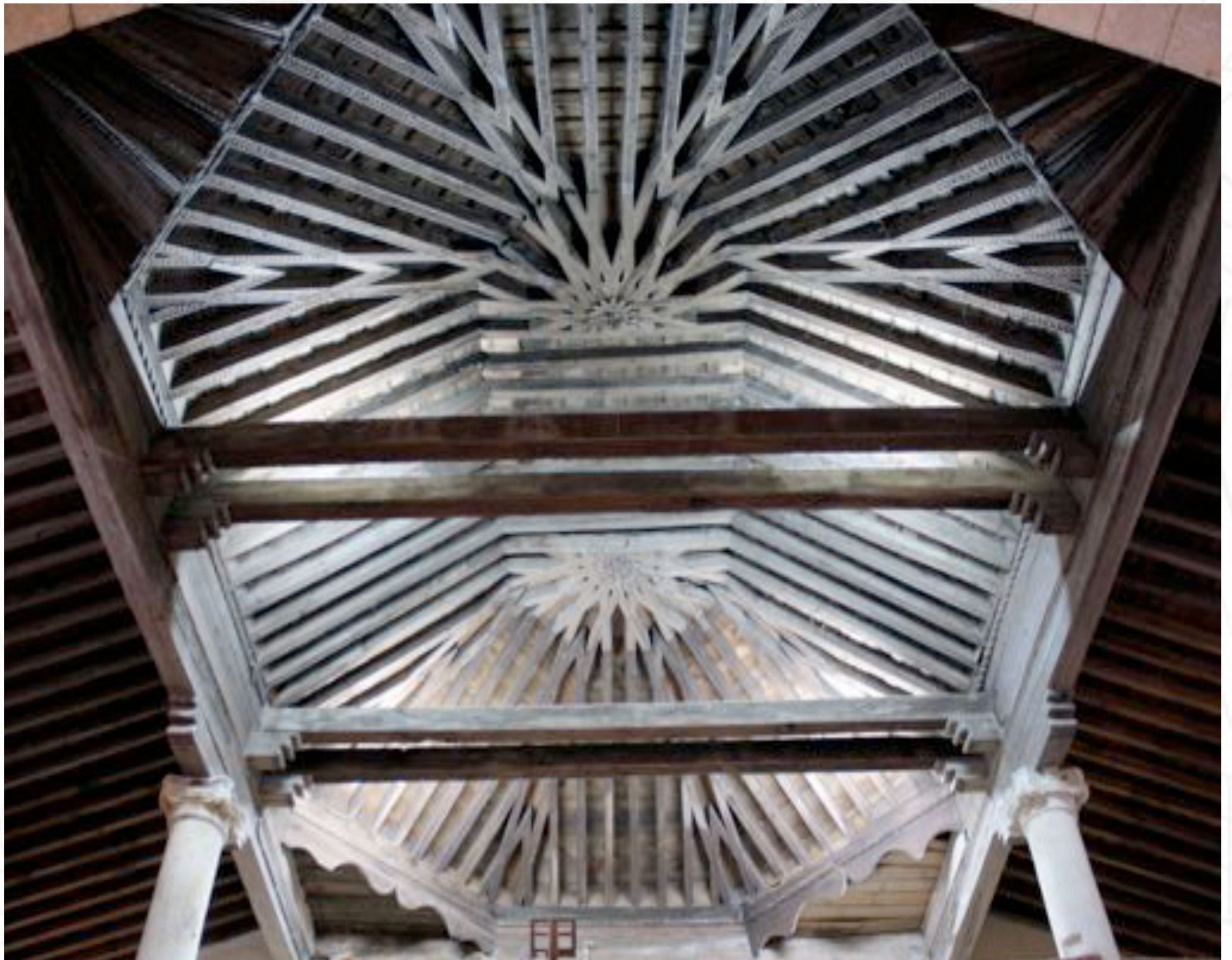
armadura de limas moamares de la nave central y colgadizos en las naves laterales. Moriscos (Salamanca)
