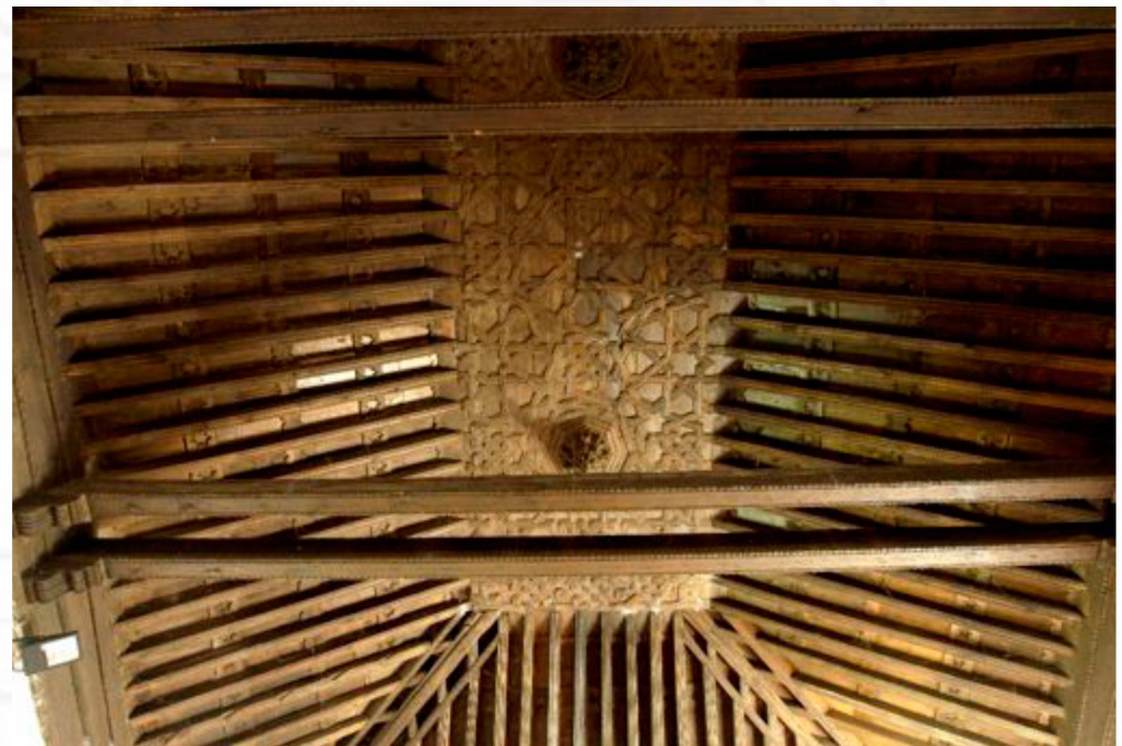
detalle de la lacería y uso de tirantes dobles
