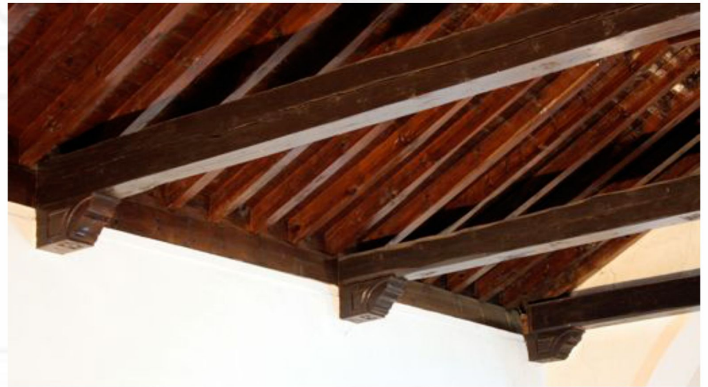
detalle de canes y tirantes de la armadura de Riego del Camino (Zamora)
