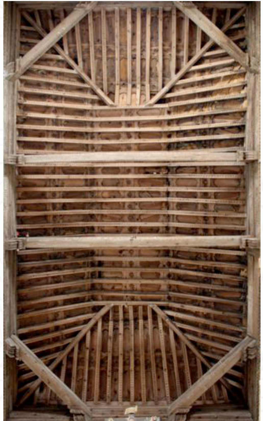
armadura de cubierta de Santa María del Castillo. Montamarta (Zamora)
