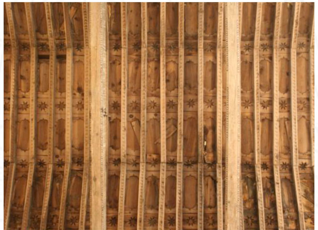
solución de cinta y saetino en los faldones inclinados y almizate
