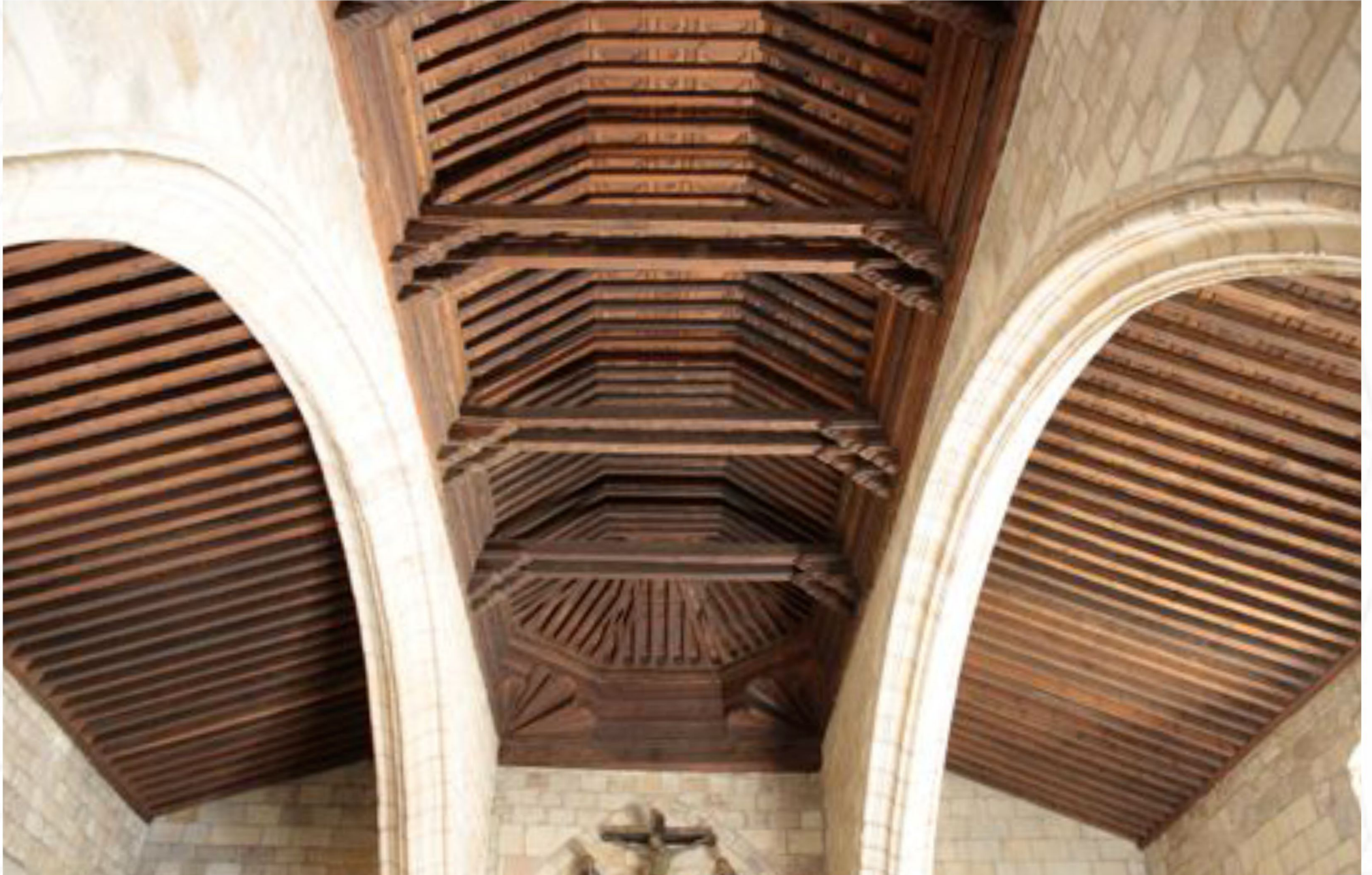
armaduras de la nave central y laterales. Iglesia de San Juan de Puerta Nueva. Zamora
