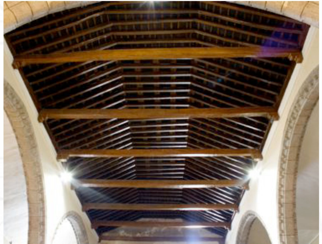
armadura de par y nudillo de la nave central
