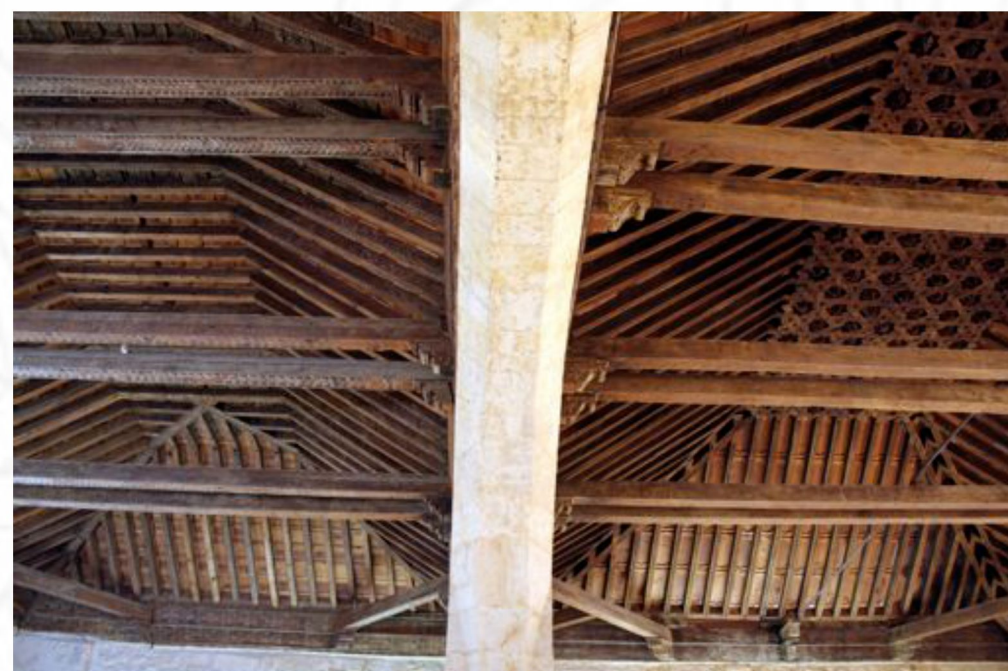
aspecto general de las dos armaduras de cubierta imagen autorizada por la Universidad de Salamanca
