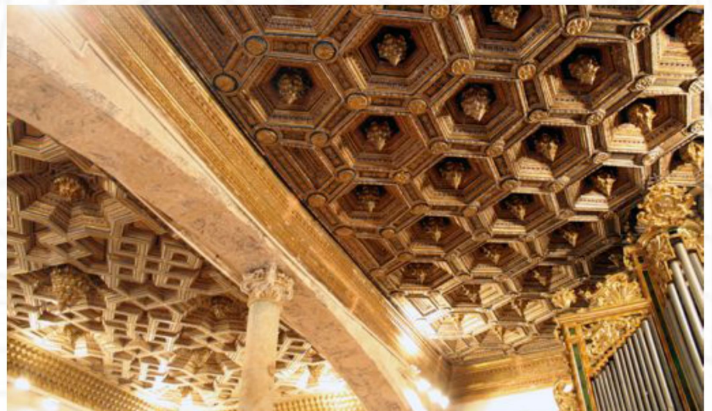
aspecto general de los dos alfarjes y su apeo sobre el arco escarzano
