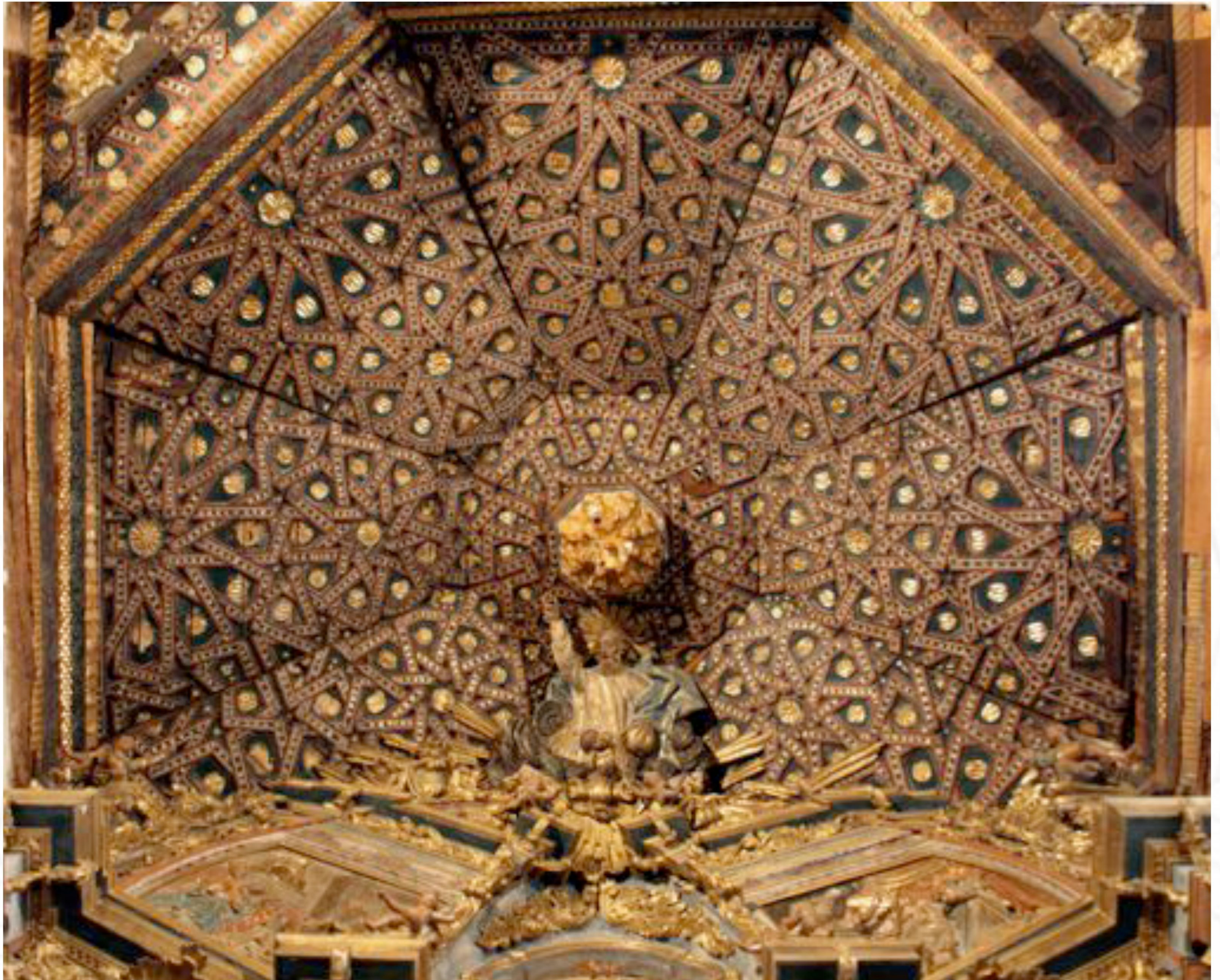
armadura de cubierta del presbiterio de Maire de Castroponce (Zamora)
