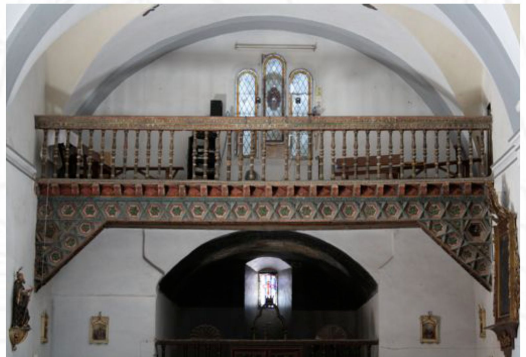
aspecto general del forjado o alfarje del coro
