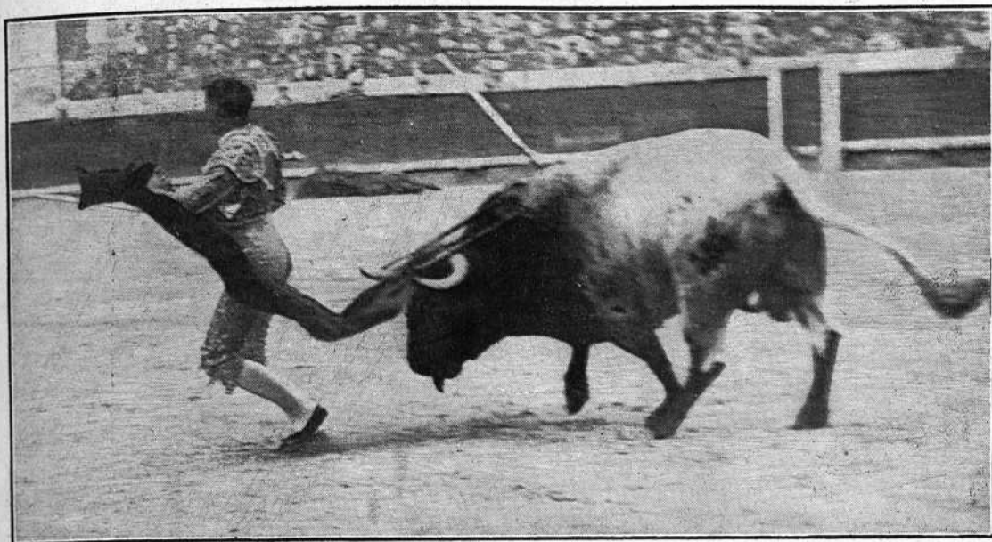
LAS ARENAS.—GAONA EN UN MOLINETE A SU SEGUNDO
