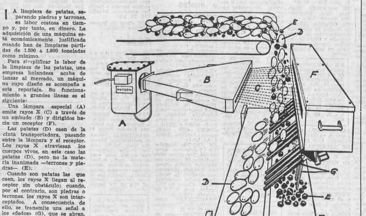
Diseño de una máquina limpiadora de patatas
