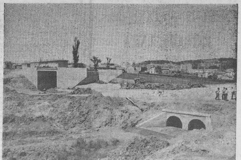
Otro aspecto de cómo van los trabajos de la "Autovía".
