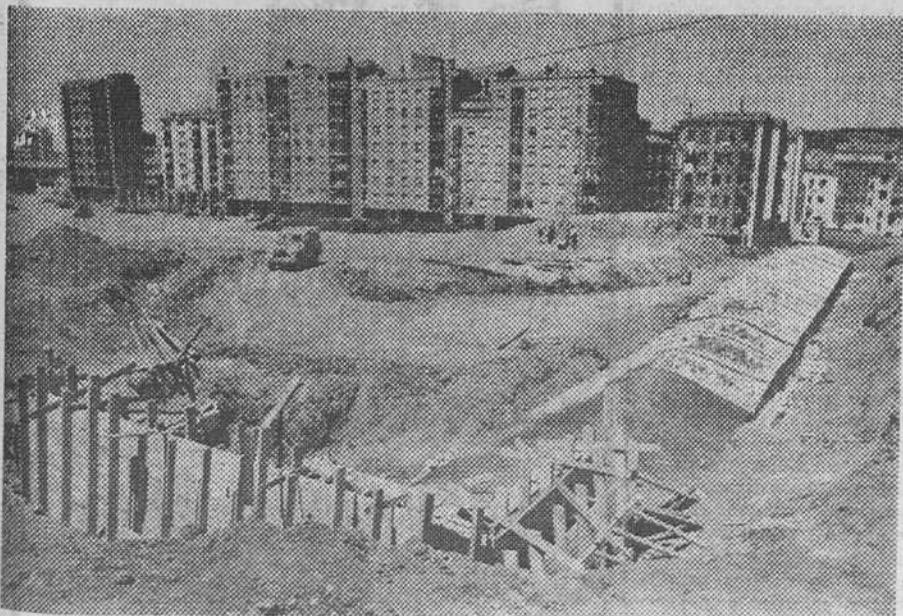
Obras de explanación para la "Vía de Ronda".
