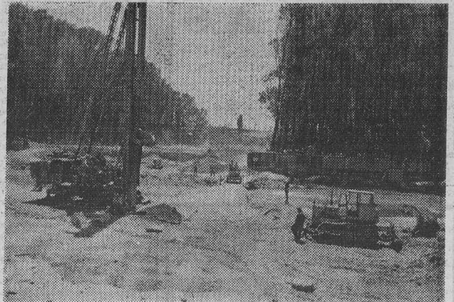
Se trabaja en un nuevo puente sobre el Arlanzón.
