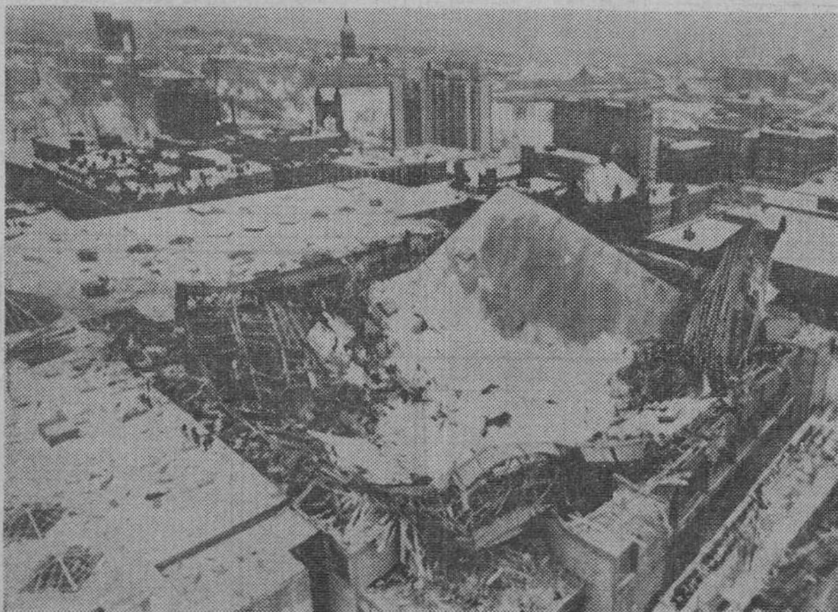
Unas cinco mil personas abarrotaban el Centro Cívico de Hartford, presenciando un partido de baloncesto, pero pudieron evacuarlo poco antes de que el techo del edificio se derrumbara. En la foto se aprecia el estado en que quedó el Centro tras el derrumbamiento. — (Telefoto CIFRA GRAFICA).
