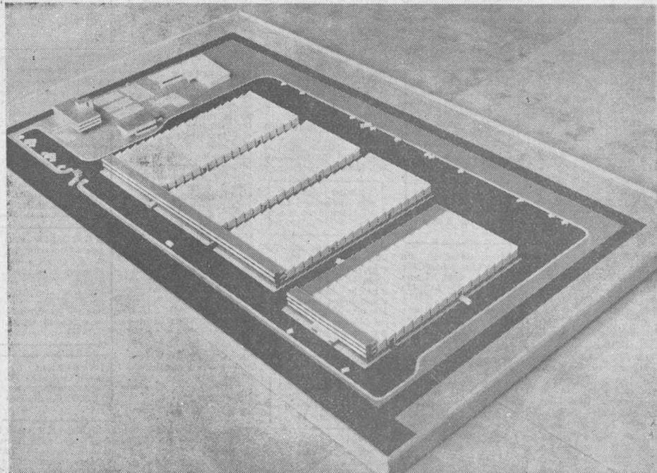
Esta fotografía nos muestra la maqueta de lo que será en total la factoría que para la fabricación de máquinas-herramientas ha previsto «NICOLAS CORREA, S. A.» en Burgos. En el grabado puede apreciarse la ampliación a realizar en el pabellón actual, los tres nuevos bloques de naves de fabricación y la zona dedicada a comedores, instalaciones deportivas de variado género y jardines.
