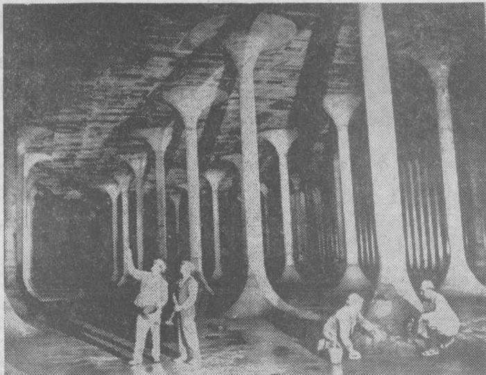
La fotografía corresponde a un depósito de agua con una capacidad para 130.000 metros cúbicos que acaba de entrar en servicio en las proximidades de Munich. 252 columnas de hormigón soportan el peso de la ciudad. Este escenario ha sido utilizado para rodar últimamente una película de James Bond, y la foto fue tomada poco antes de que las aguas lo llenasen. — (Foto FIEL)
