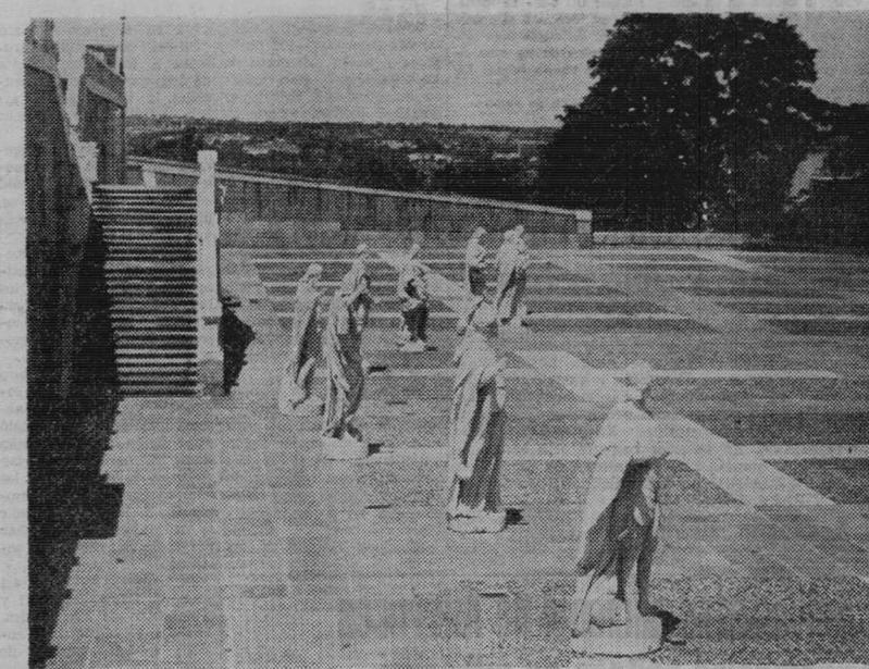
Varias de las estatuas que han sido colocadas en la fachada del Palacio Real de Madrid, esperan a ser izadas por una potente grúa hasta su correspondiente base, en los ángulos del edificio.
