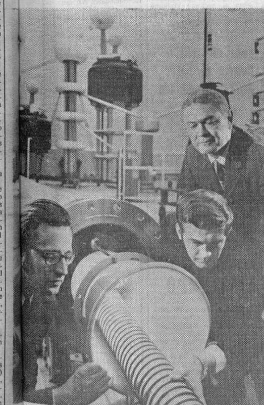
Aluminio de 40 pies de longitud, enfriado a 320° F., bajo cero, ha resistido hasta 435.000 voltios durante los experimentos realizados por ingenieros de Investigación de la General Electric en Nueva York. Los primeros en transmitir energía (temperatura muy baja) en proporciones comerciales con la posibilidad de utilizar este tipo de cables superfríos, subtransmitir gigantescas cantidades de energía a zonas urbanas congestionadas. — (Foto Fiel)
