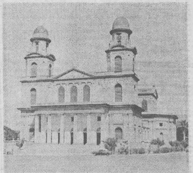
La Catedral de Managua, erigida en 1940 y que sustituyó a la primitiva, destruida por otro violento seísmo en 1931. En el terremoto de la madrugada de ayer, el templo catedralicio también ha sufrido graves daños.
