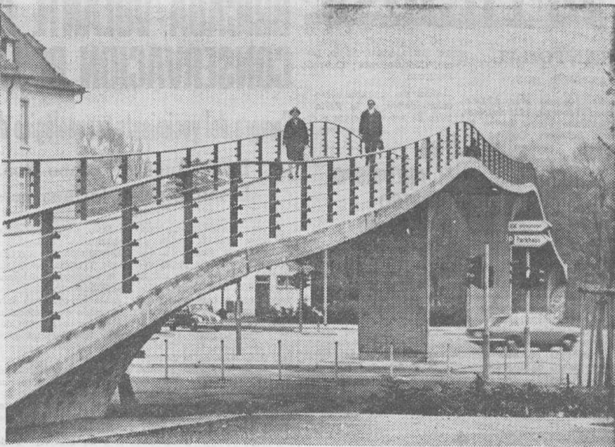
En la ciudad alemana de Friburgo, como en tantas otras, uno de los más importantes problemas es el del tráfico. Para evitar peligros en los cruces de las carreteras y hacer más fluida la circulación por ella, también allí se construyen pasos elevados para los peatones. Pero no pasos elevados antiestéticos. He aquí una muestra. El puente que cruza la carretera tiene formas onduladas, no desmerece al paisaje y las construcciones cercanas y es doblemente útil para los peatones porque al carecer de escaleras pueden pasar por él con los carritos de sus compras o los cochecitos de los bebés. — (Foto Fiel)
