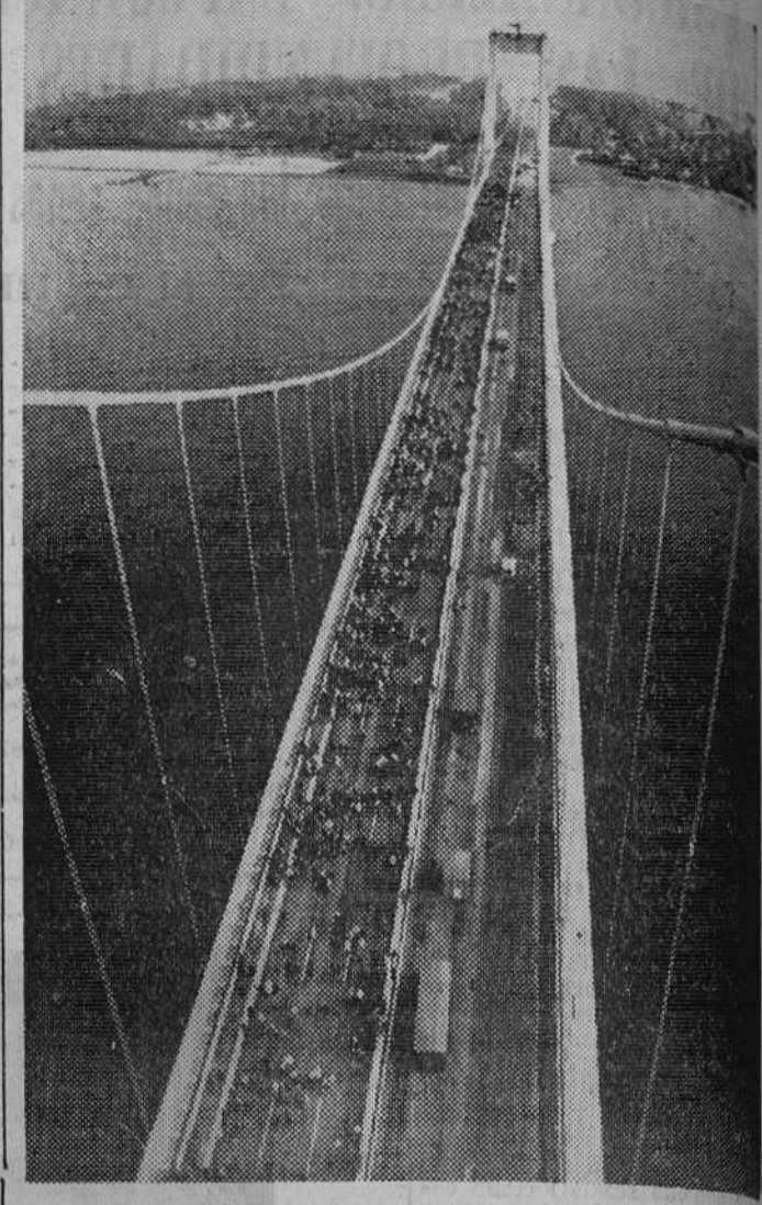
Ha sido inaugurado un nuevo y gigantesco puente entre Jylland y Fyn, en Dinamarca. Millares de personas pasearon por él por primera y última vez ya que ha sido construido para su utilización exclusiva por automóviles. Cada persona tuvo que pagar por el paseo dos coronas, ya que la inauguración estaba organizada a beneficio de la Cruz Roja. La foto muestra una panorámica del puente con el público paseando por una de las calzadas. — (Foto Fiel)
