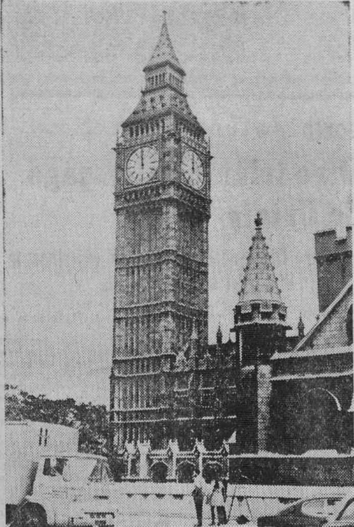
Una de las imágenes más conocidas de Londres es la de la torre del «Big Ben», en el edificio del Parlamento. Pues bien, el famoso «Big Ben» también se inclina y durante los 130 años de su existencia su cúspide se ha desviado 37 centímetros del eje vertical. Sin embargo parece que no hay peligro, entre otras cosas porque durante los últimos cinco años la desviación no ha sido más que de un milímetro escaso. La campana de la torre pesa más de tres toneladas. — (Foto FIEL).
