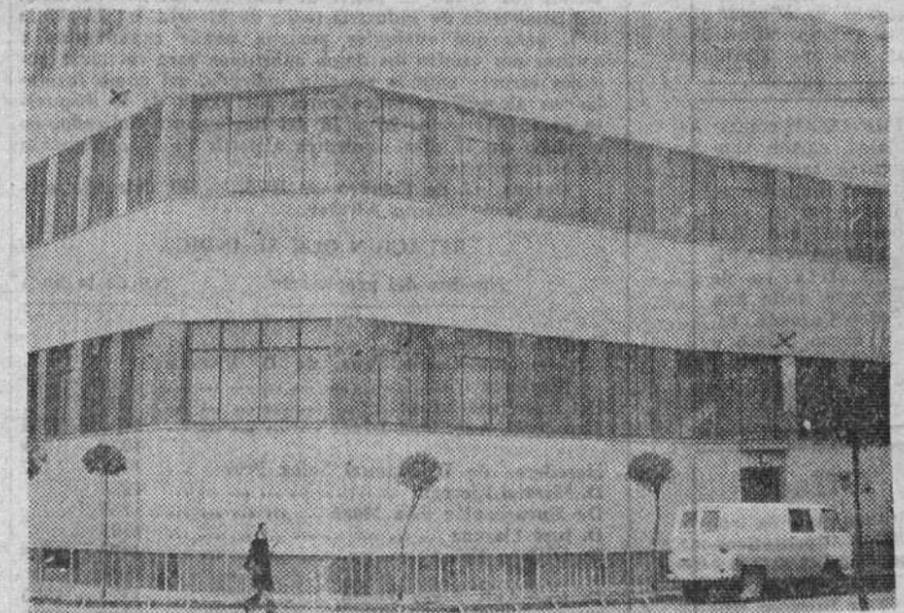
Corresponde al soberbio edificio de la Compañía Telefónica, de reciente construcción. Como puede verse en la foto de Juan Muro —señaladas con flechas— en varias partes de la fachada, se han desprendido las losetas de mármol, lo que ha hecho que se coloquen en las aceras unas vallas de protección, en evitación de posibles accidentes a los peatones. ¿Se colocaron mal estas losetas? Eso no lo sabemos, pero es evidente que estas fachadas requieren un examen y su posterior arreglo.
