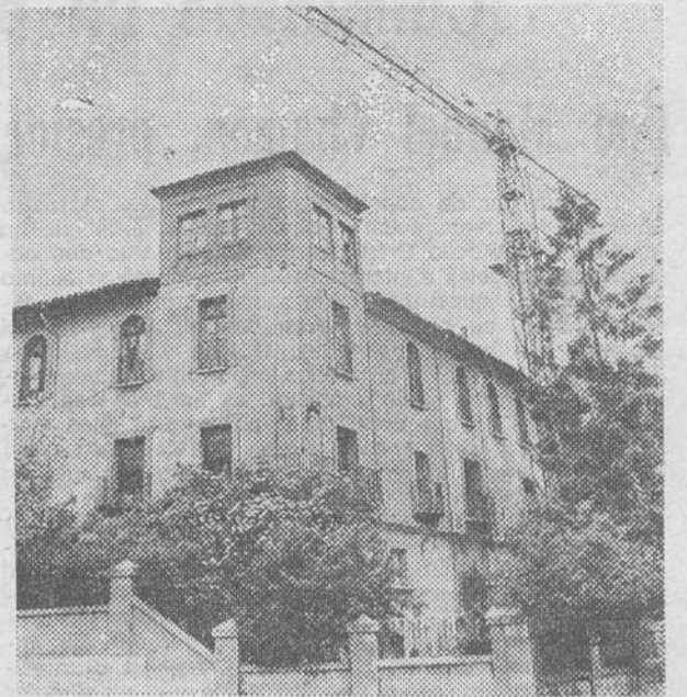
¿Será Archivo Municipal? El Palacio de Castilfalé reúne condiciones para ello. Por el momento, el Ayuntamiento está realizando obras de consolidación del edificio. — (Foto FEDE).
