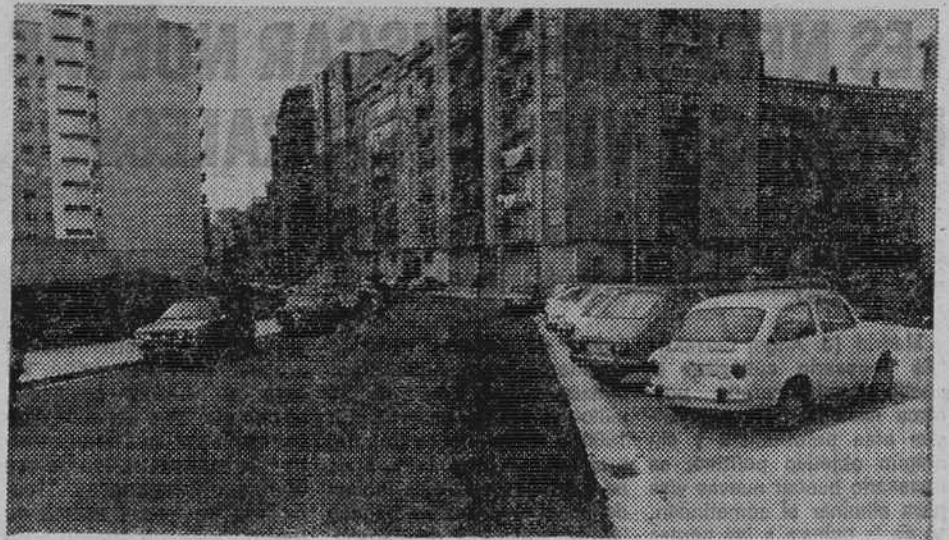
Esta es la calle Federico Martínez Varea que acaba de ser objeto de importantes obras de urbanización por parte del Ayuntamiento y cuyos trabajos han terminado ya. (Foto FEDE)
