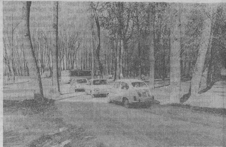
Este es el nuevo acceso que desde el último tramo de la calle de San Pedro de Cardeña conduce al paseo de La Quinta. Los trabajos han sido realizados por la Brigada Municipal de Obras y falta proceder a asfaltar la calzada. — (Foto FEDE).
