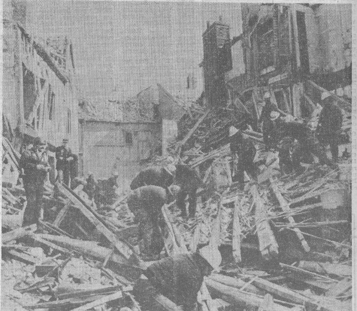
Joigny (Francia). — Miembros del equipo de bomberos y varios soldados se afanan en las tareas de desescombro, tras la explosión de gas ocurrida el pasado martes en el centro de la ciudad de Joigny, que afectó a cinco casas destruyéndolas casi por completo y causó graves heridas a cinco personas. Joigny está situada al Suroeste de París. — (Telefoto EFE-AP).
