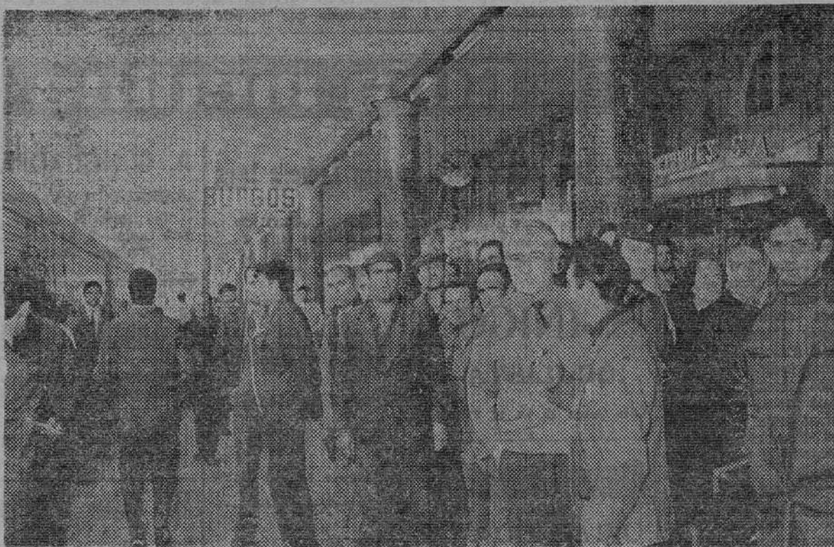
La estación «Burgos-Avenida» o común de la RENFE es notable por su actividad dentro de la red nacional. En lo que se refiere al tránsito de viajeros, dada la situación de nuestra ciudad y la limitación actual en cuanto a expendición de billetes y reservas para todos los trenes y todas las posibles combinaciones y para los empalmes en Miranda, tendrá mucha importancia la resolución del problema planteado por la necesidad de contar con un despacho central adecuado y dotado de todos los servicios técnicos precisos. Este es uno de los temas que se tratan en el presente trabajo. — (Foto Archivo).
