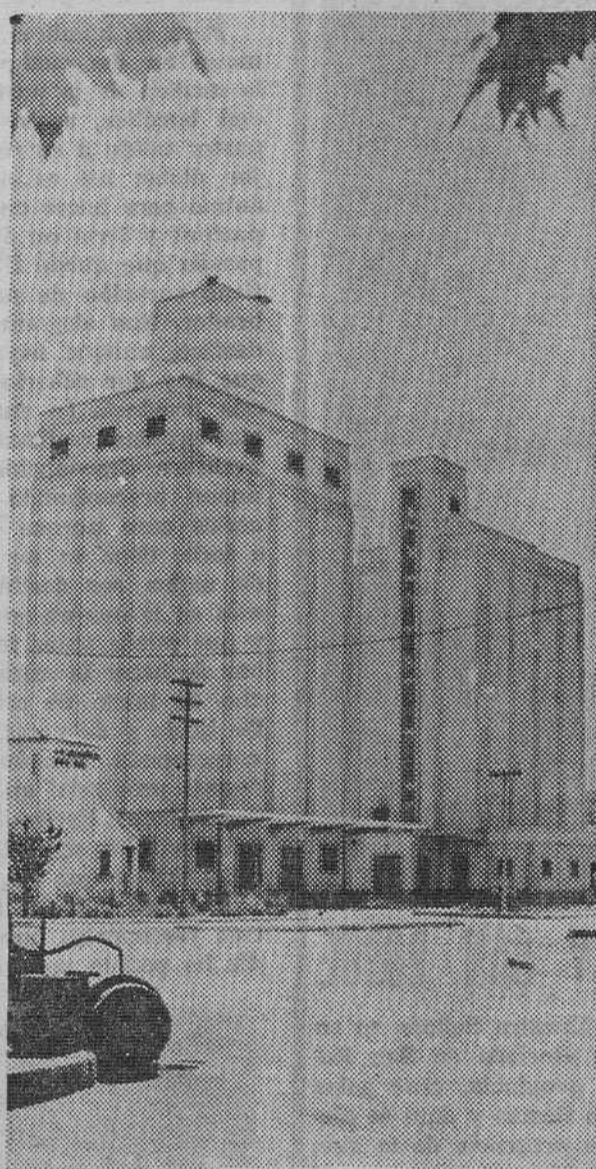
Silo de Briviesca.
