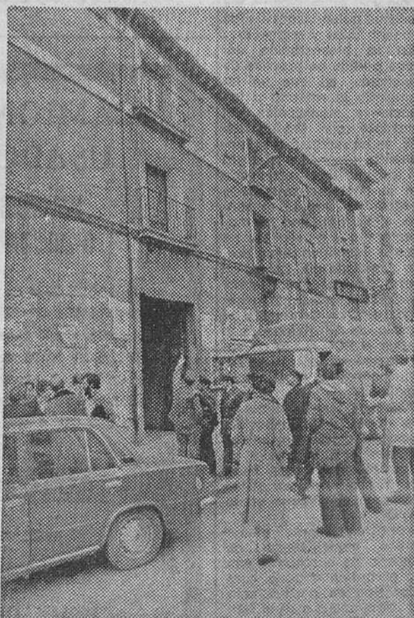
La Policía municipal y los bomberos inspeccionan el estado del edificio tras el hundimiento de una parte del segundo piso. — (Foto FEDE)
