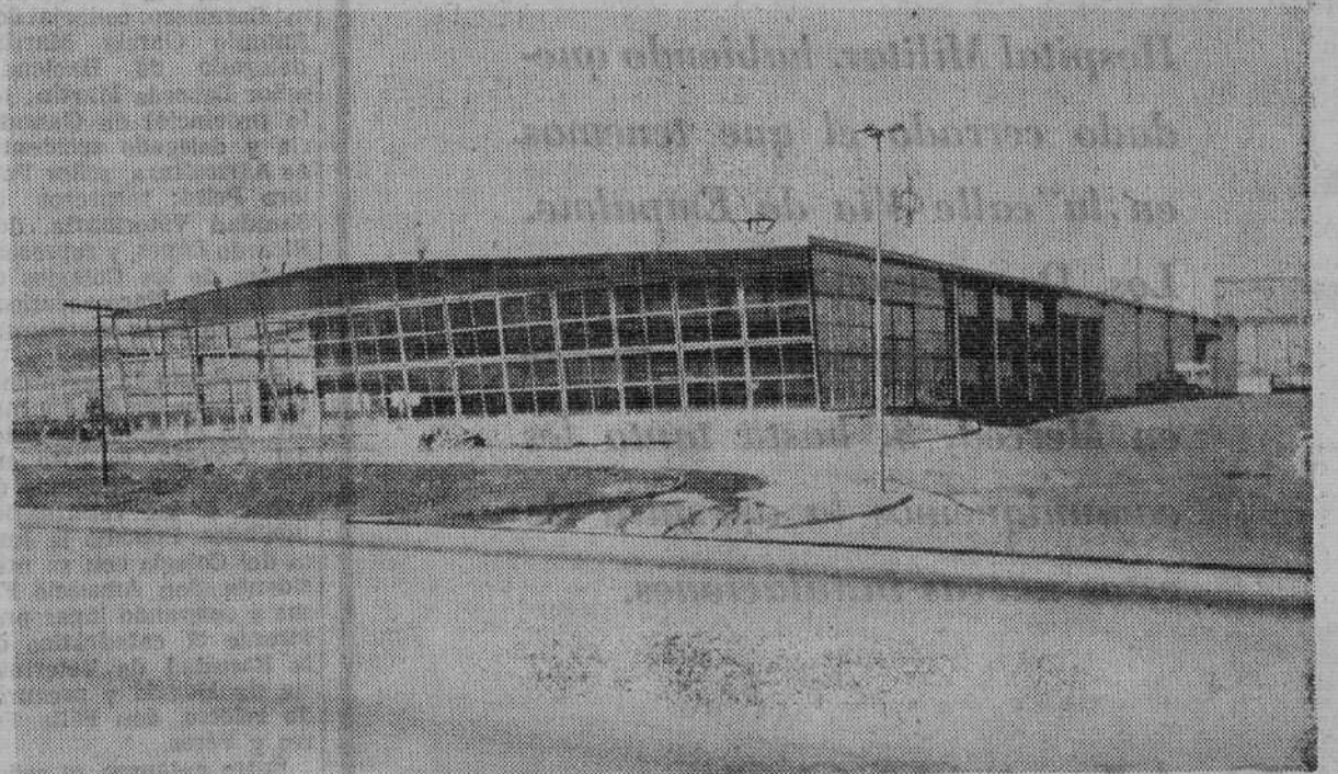
Estado de las obras de las nuevas instalaciones de «Palacios Auto Agrícola», prácticamente terminadas.
