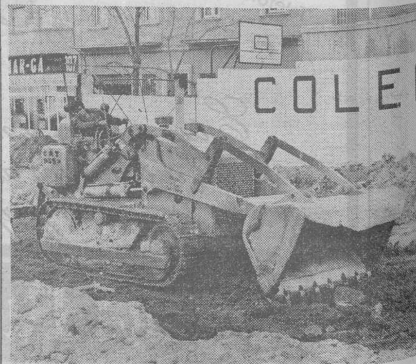
Las estruendosas máquinas de la construcción. — (Foto EFE-FIEL).
